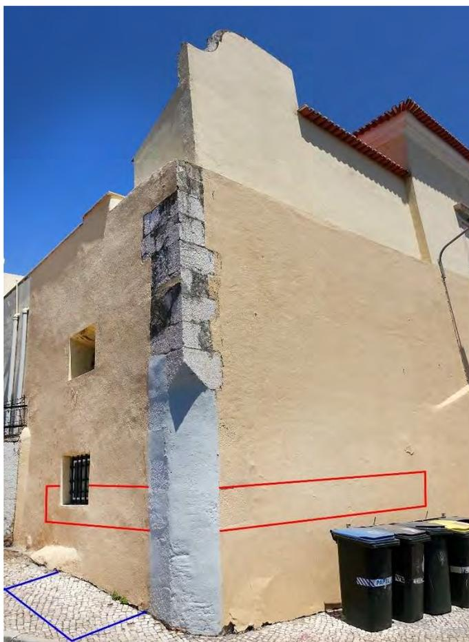
Figura 38 – Disposição das sondagens parietais, a vermelho, e da sondagem arqueológica, a azul, junto do cunhal sul do edifício.
