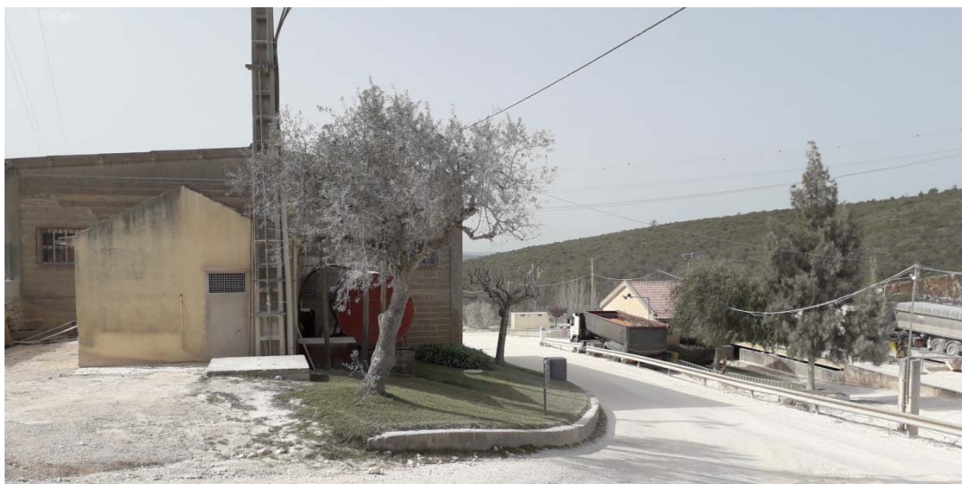
Fotografia 13 – Vista do edifício de manutenção (lado esquerdo) e do edifício de escritório anexo à báscula de pesagem (lado direito).
