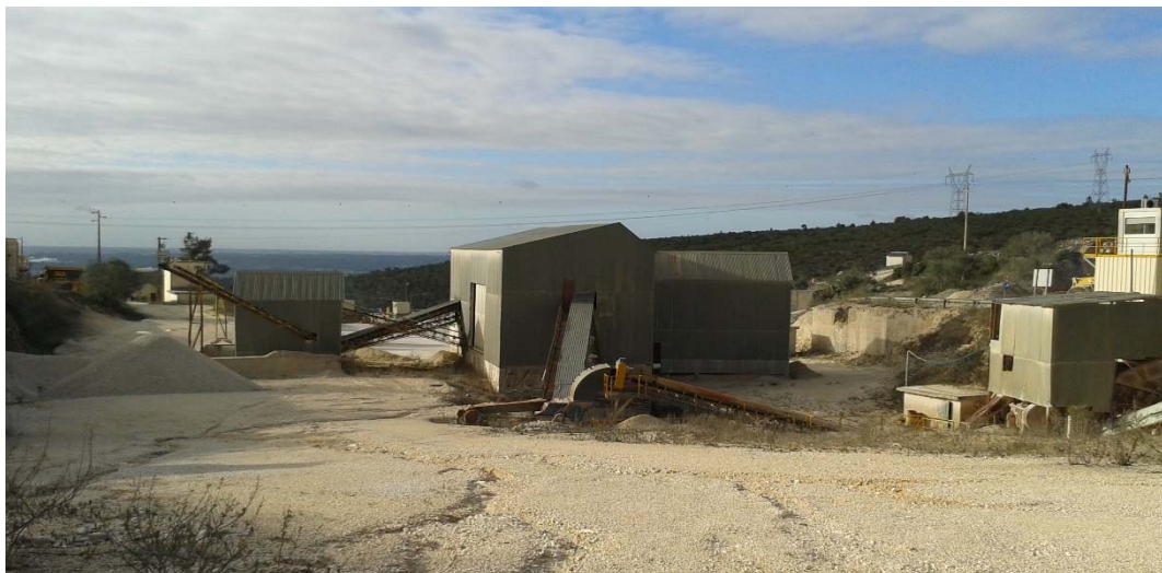
Fotografia 7 – Vista do módulo I da instalação de britagem.
