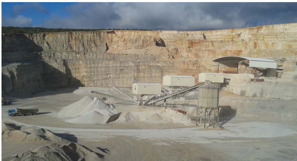
Fotografia 10 – Vista do módulo IV da instalação de britagem.
