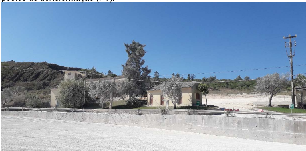
Fotografia 15 – Vista da casa de arrumos e, em segundo plano, do armazém e de um dos postos de transformação (PT).
