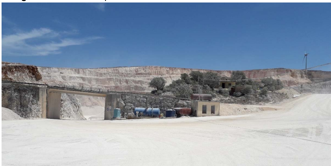
Fotografia 14 – Vista do posto de abastecimento de combustíveis.
