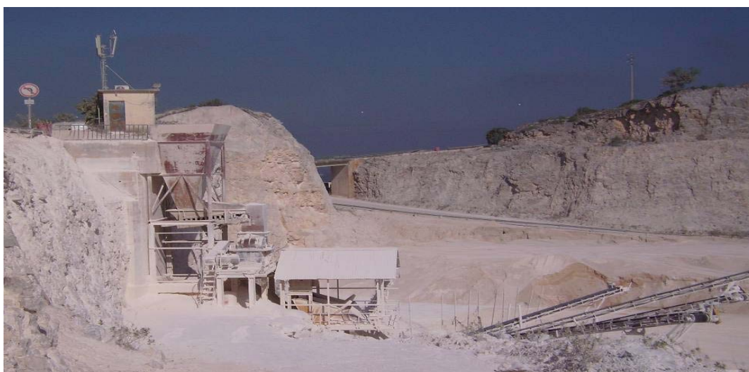
Fotografia 9 – Vista do módulo III da instalação de britagem.
