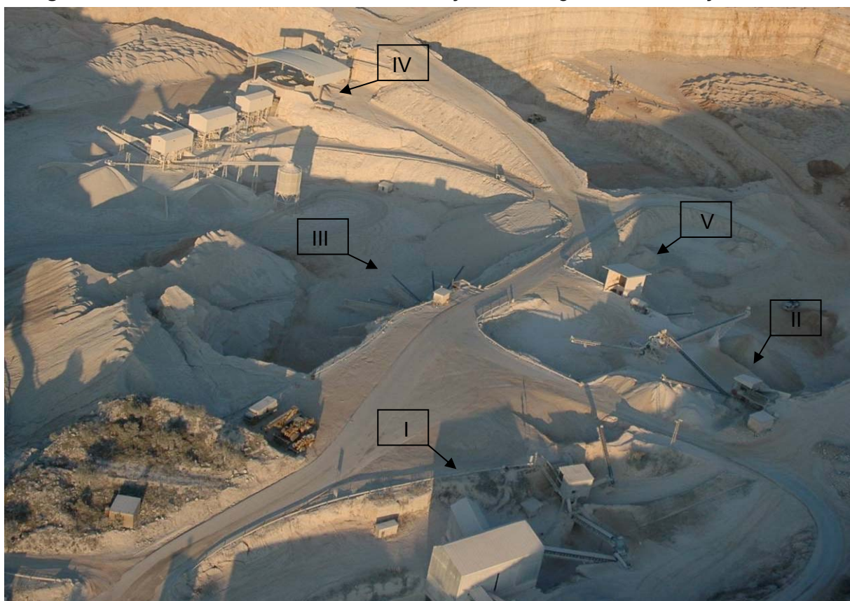
Fotografia 6 – Vista área dos módulos da instalação de britagem e classificação.
