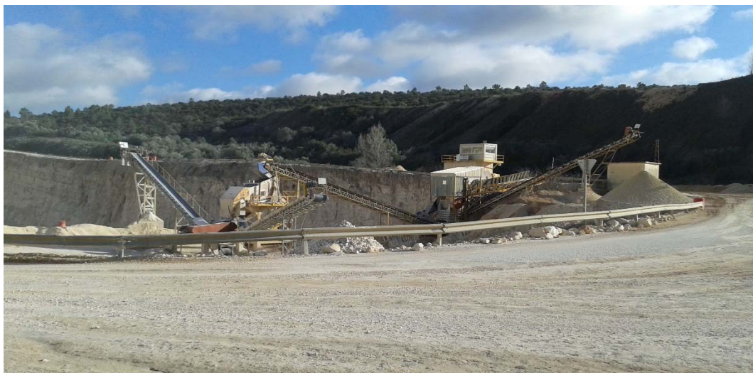
Fotografia 8 – Vista do módulo II da instalação de britagem.
