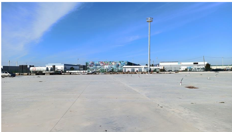
Fotografia 4 – Vista norte, zona industrial
