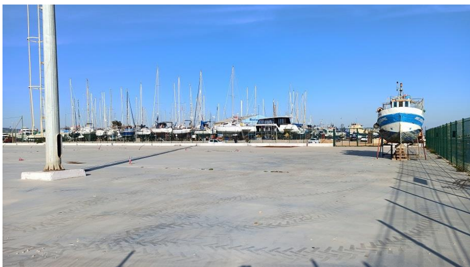
Fotografia 3 – Vista nascente, estaleiros navais
