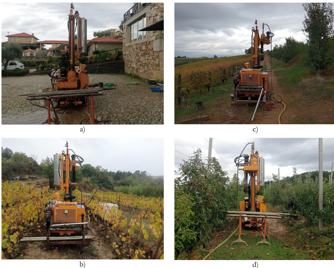
Figura 6 – Execução dos furos de sondagem: a) S1; b) S3; c) S10 e d) S14.
