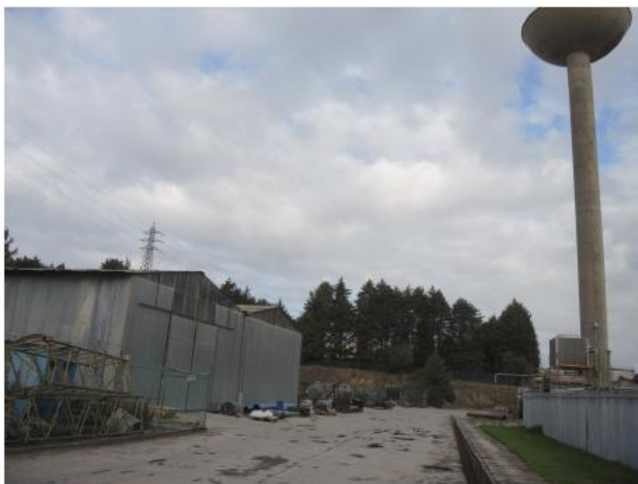
Fot.1 – Vista geral da área onde será instalado o armazém CA5.
