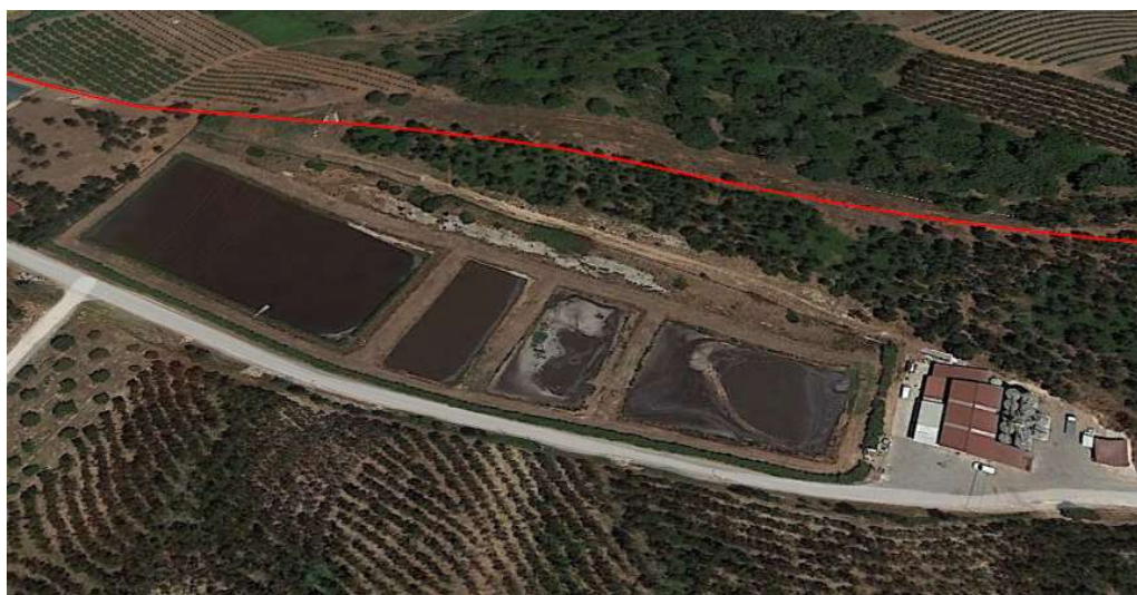
Figura I.10 Sistema de retenção de efluentes pecuários do NP1 e NP3.
