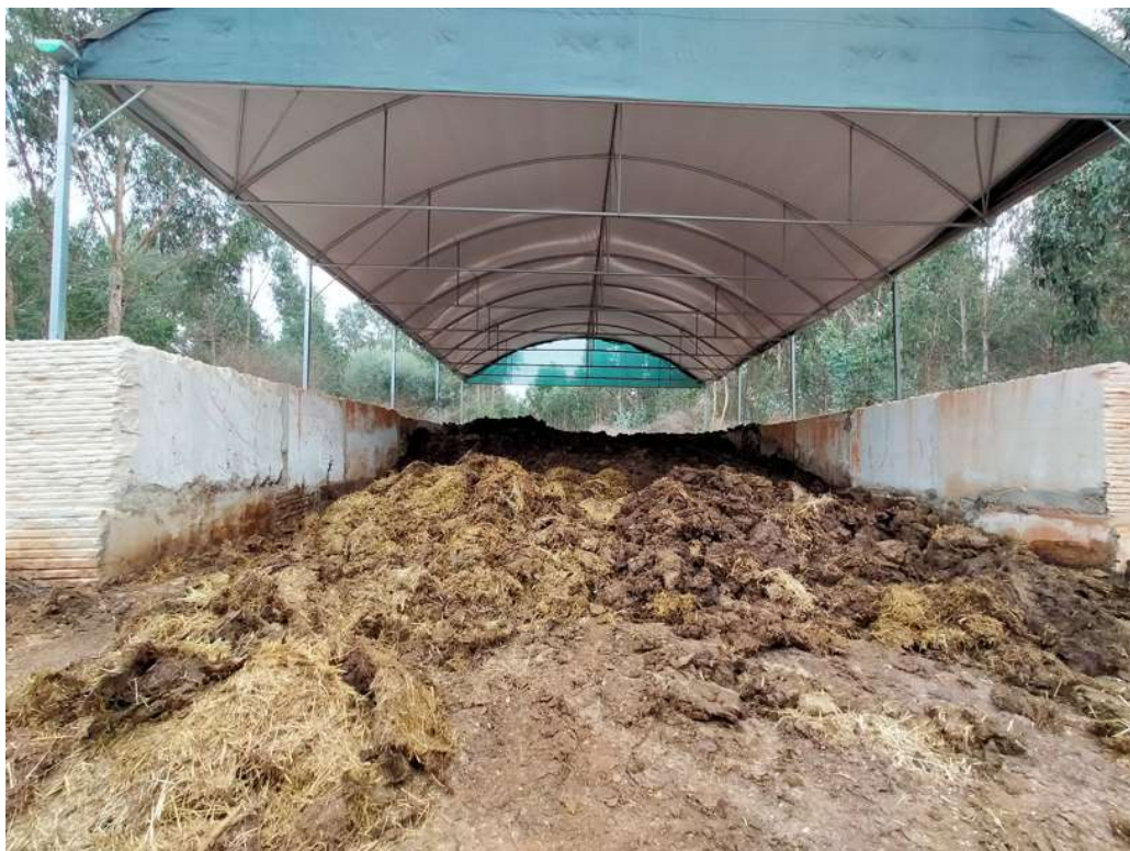
Figura I.12 - Placa de estrume para armazenamento do estrume do NP4 e reforço para o estrume do NP1, 2 e 3.
