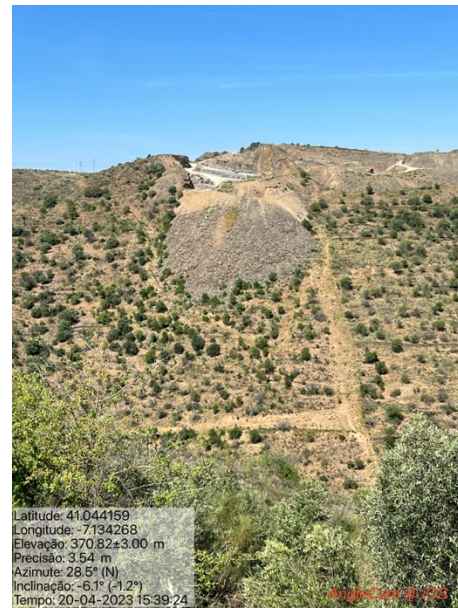
Figura 5: Fotografias da escombreira existente a sul evidenciando a implementação da medida de reperfilamento da escombreira.
