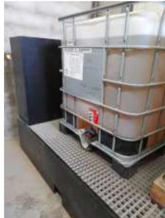
Figura 2 - IBCs sobre bacia de retenção na área técnica de anodização
