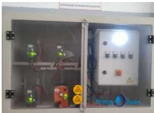
Figura 4 - Sistema de doseamento automático da lacagem vertical
