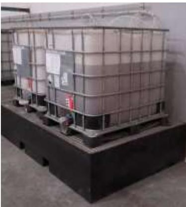
Figura 3 - IBCs sobre bacia de retenção na área técnica da lacagem vertical
