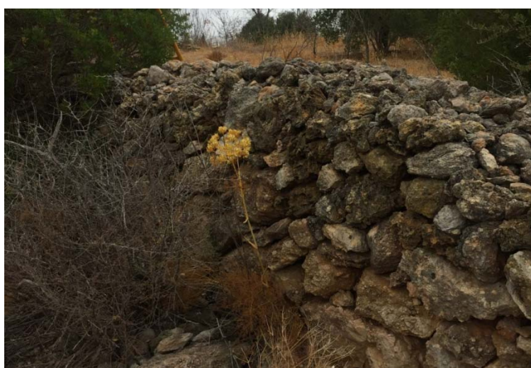
Figura 73 - Troço de muro de pedra seca
