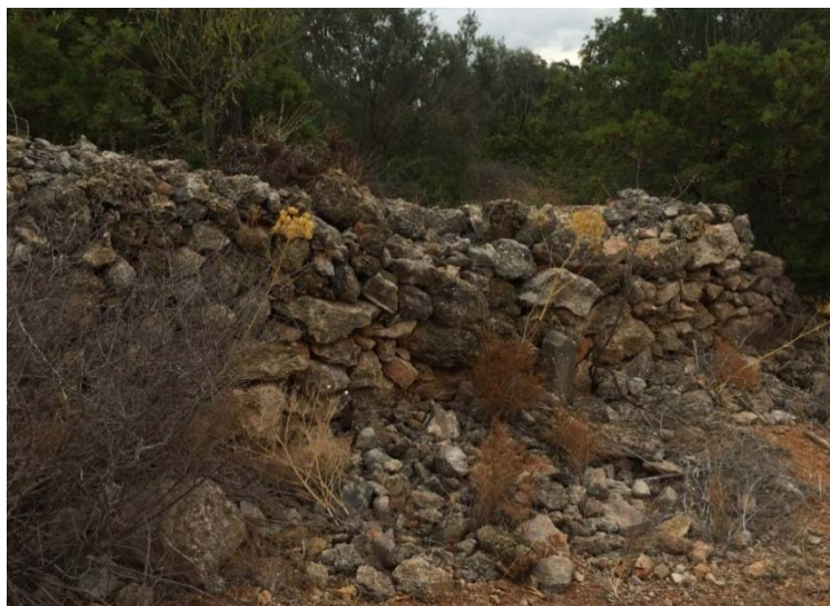
Figura 72 - Muros de pedra seca.
