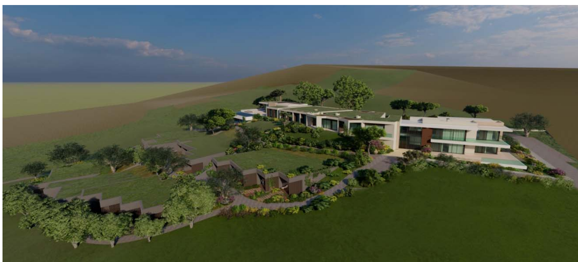
Figura 1 - Vista geral do Empreendimento Turístico.
