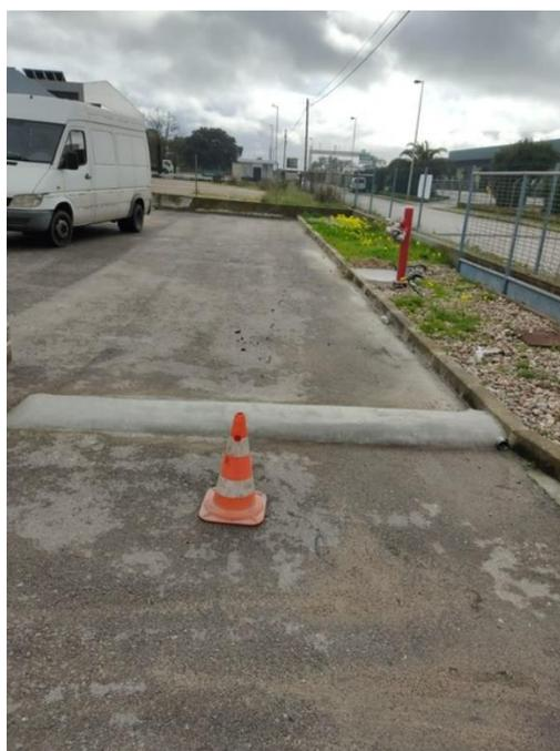
*Figura 7 - Lomba de contenção de derrames durante a carga / descarga de camiões (Armazém J)*
