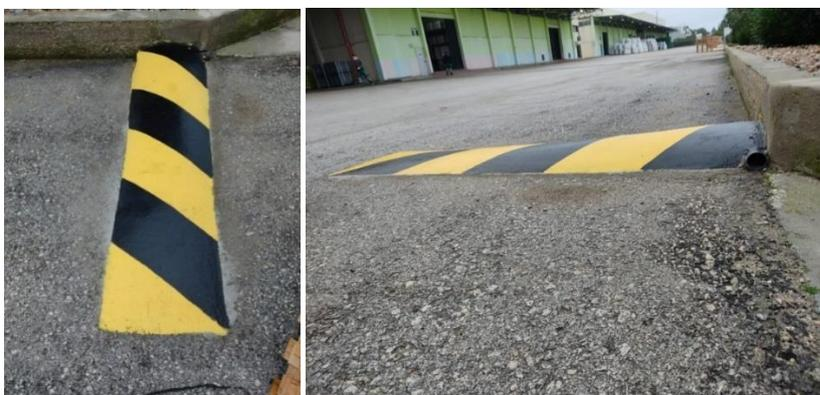
**Figura 6 - Lombas de contenção de derrames durante a carga / descarga de camiões (Armazéns D e E)**
