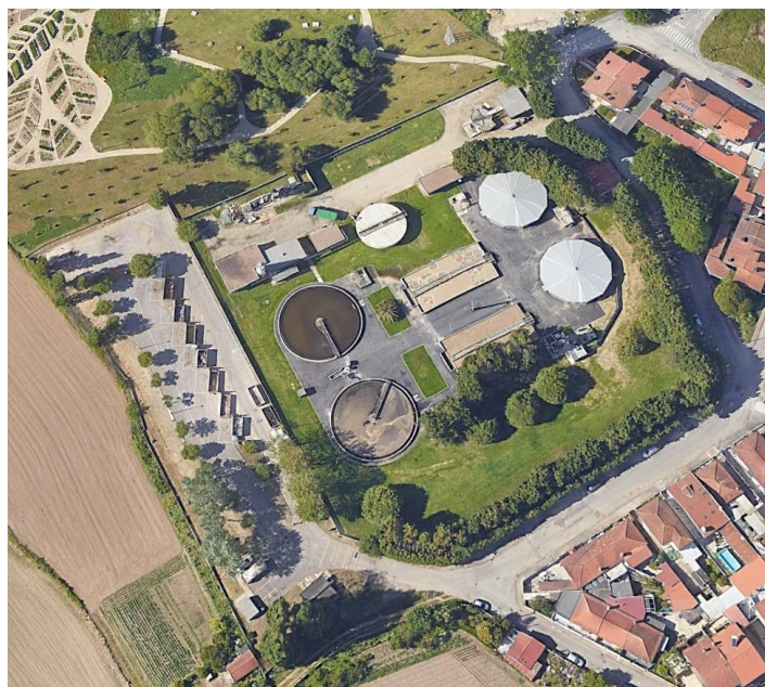
Figura 2.1 – ETAR de Ermesinde (Fonte: Google Earth Pro, Latitude: 41°13'25.41" N, Longitude: 8°33'32.26" O)
