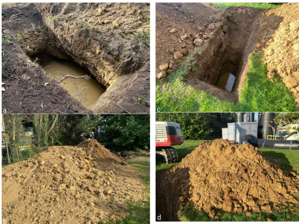
Figura 12.3 - Pormenores dos poços de reconhecimento (a, b - Poço 1; c, d - Poço 2)
