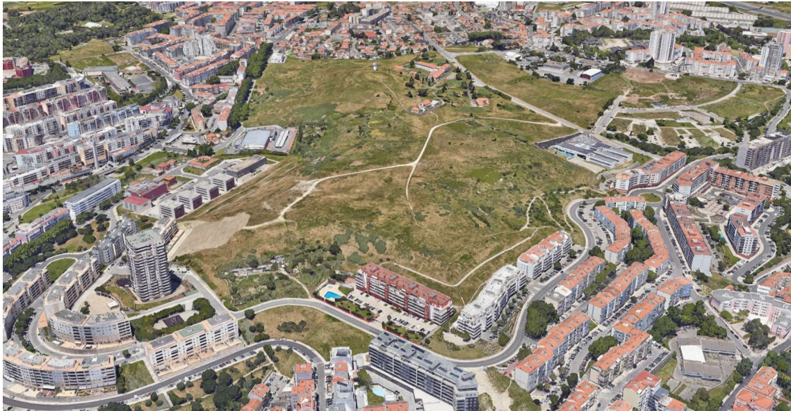
Foto 15 – Vista Noroeste/ Área de Intervenção (fonte: googleEarth)
