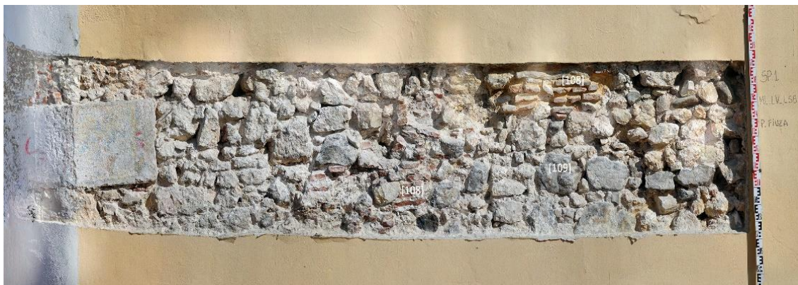
Figura 42 – Plano final da SP1 onde se observa o aparelho construtivo da fachada.
