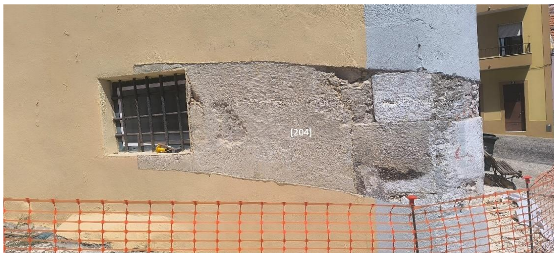
Figura 45 – Unidade [204] composta por argamassa cimentícia.
