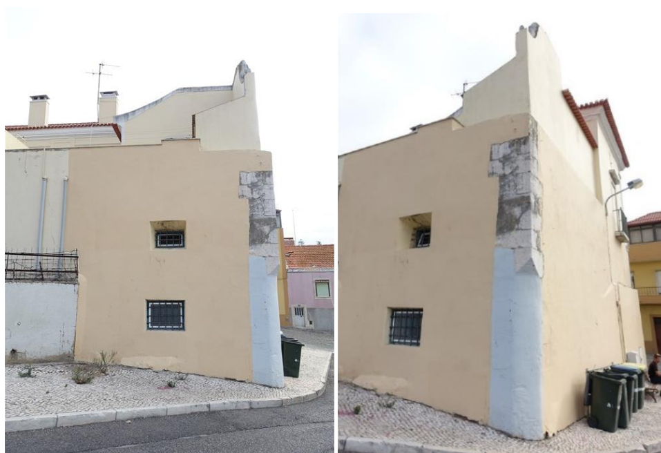
Figura 12 – Palácio Fiúza: corpo cuja demolição está prevista.
