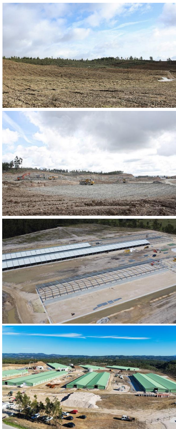
Figura 5. Exemplos das fases de obra de construção de uma instalação avícola.
