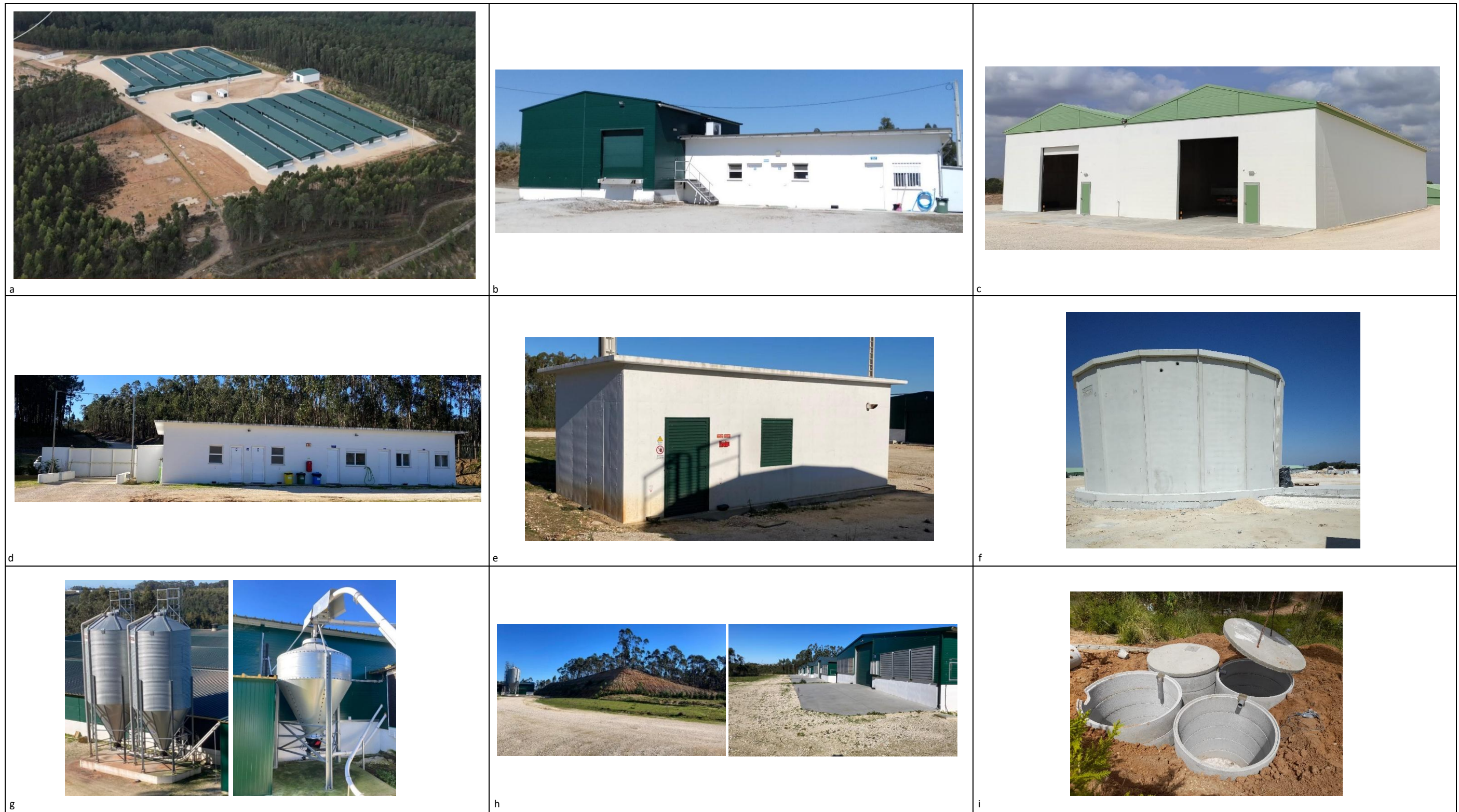
Figura 2. Exemplos de (a) grupos de pavilhões avícolas; (b) edifício de apoio e armazém de ovos; (c) armazéns independentes contíguos; (d) filtro sanitário; (e) edifício do quadro geral (parcial) e do gerador de emergência; (f) reservatório de água de 500 m 3 ; (g) silos principais e pequenos; (h) áreas exteriores pavimentadas em betão e ABGE/tout-venant; e (i) fossas estanques enterradas em betão.
