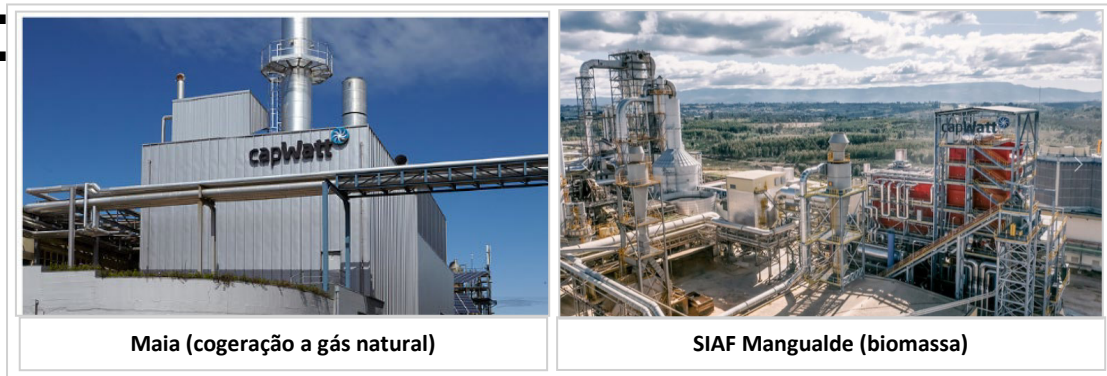
Foto I.1 – Exemplos de centrais de energia da CapWatt
