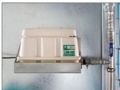
Figura III.16 – Soprador para dessulfuração interna
