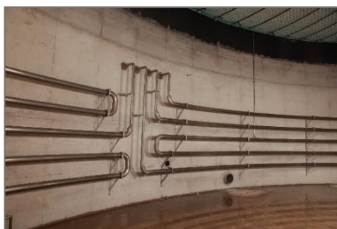
Figura III.8 – Serpentinhas de Aquecimento Internas
