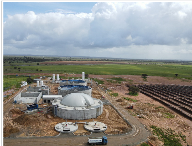
Foto I.3 – Unidade de produção de biometano em Aljustrel (em construção)
