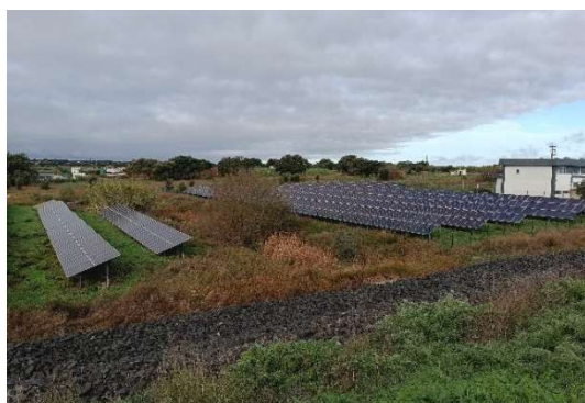
9 –UPAC associada à Estação Elevatória da Barragem
