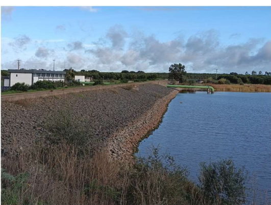
8 – Estação elevatória junto à Barragem do Monte do Marmelo
