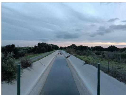
7 – Canal de rega da ABORO próximo da Barragem do Monte do Marmelo
