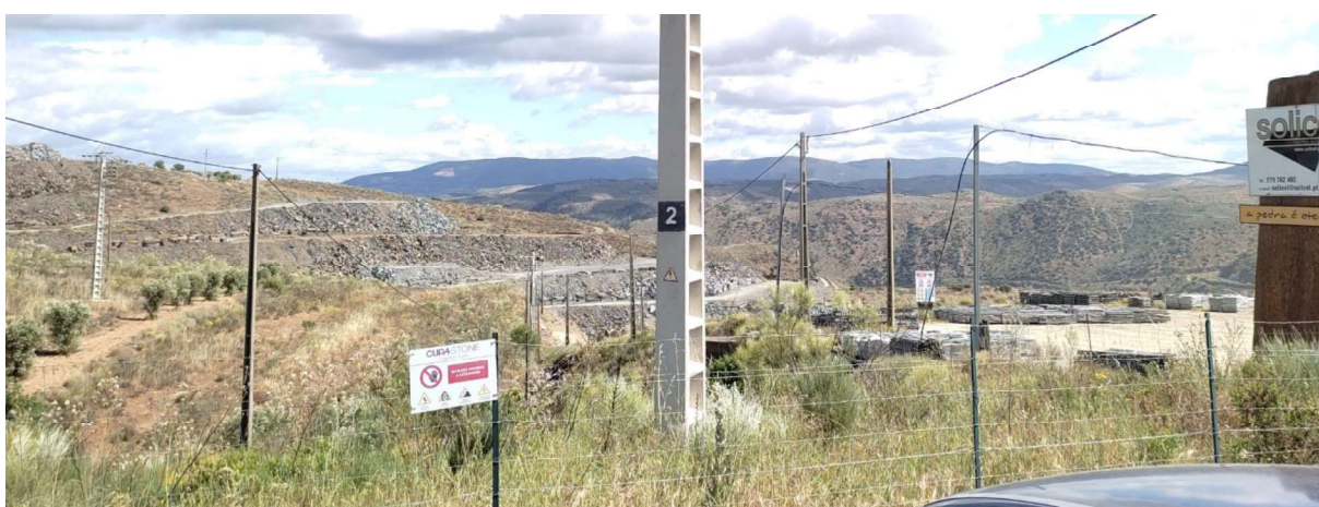
F19 - Núcleo de Pedreiras do Poio
