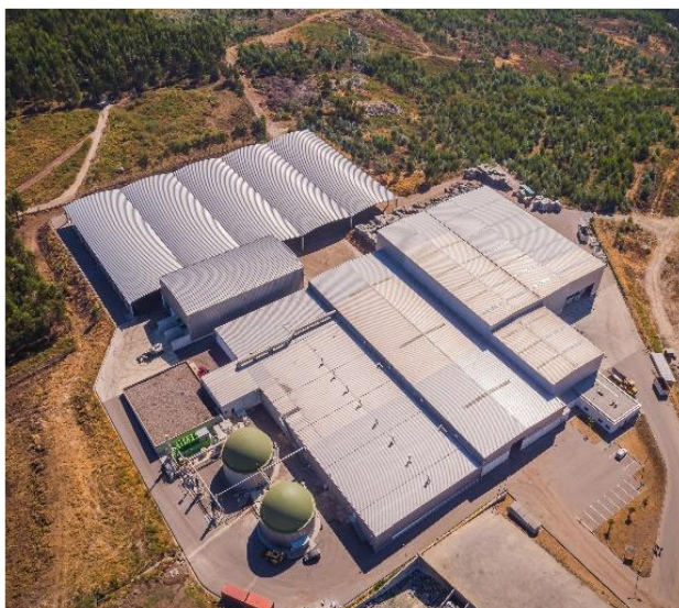
Figura 3 - Central de Valorização Orgânica/ Tratamento Mecânico
