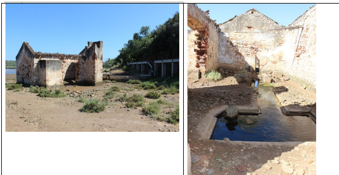
Figura 30 – Conjunto agrícola composto por edifício, tanque, poço e levada (imagem da esquerda); pormenor do tanque no interior do edifício (imagem da direita)
