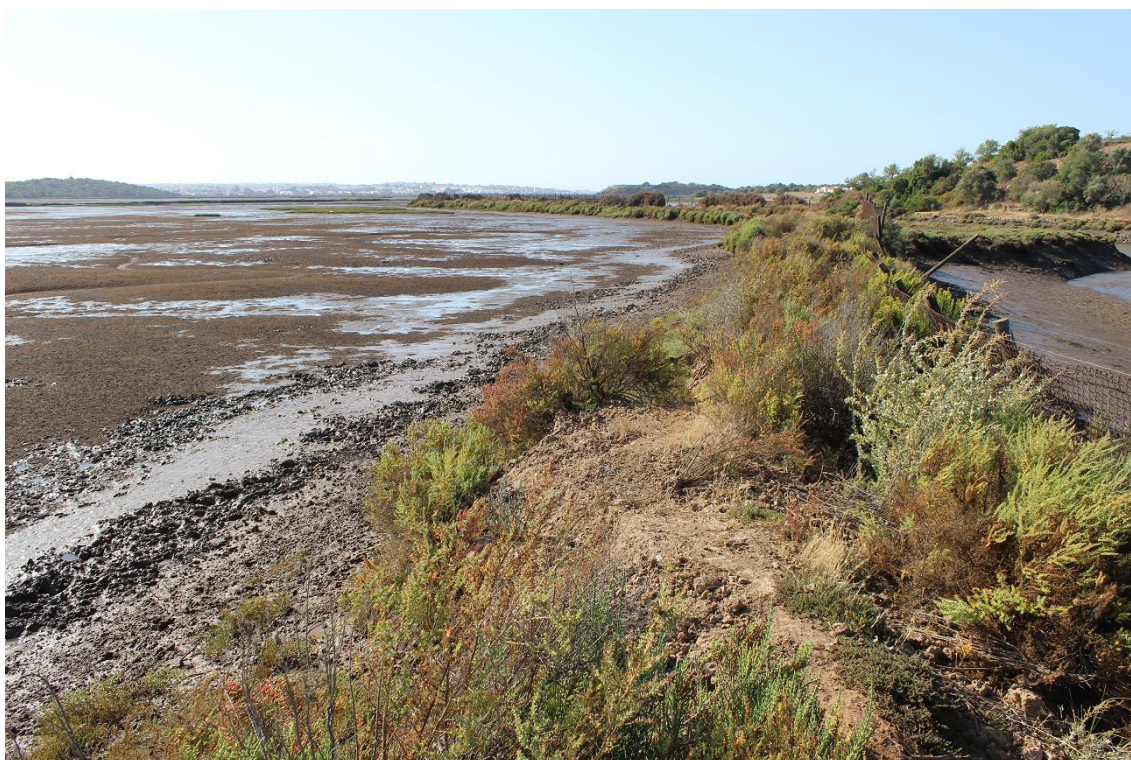
Figura 54 – Aspeto do dique na Maromba com a ribeira de Boina à direita na imagem.
