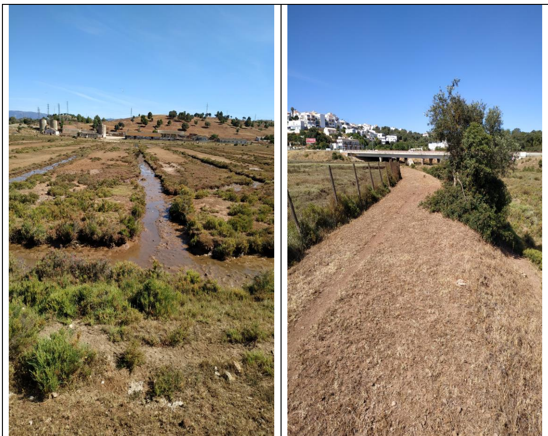
Figura 60 – Aspeto dos campos com valas e dique bem preservados
