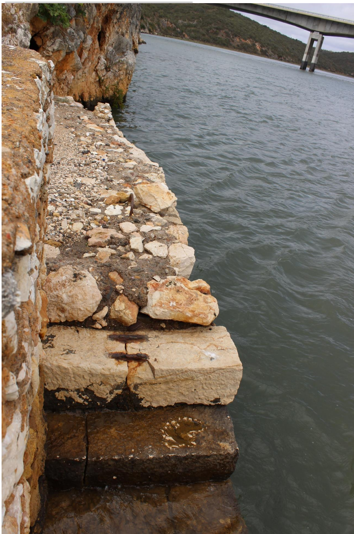
Figura 49 – Pormenor da escadaria em pedra apresentando reparações.
