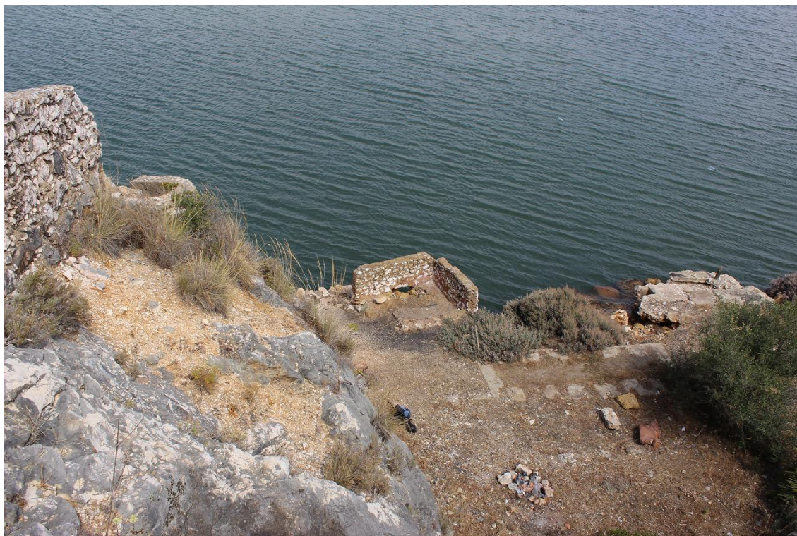
Figura 48 – Vista de cima da zona do cais onde é visível uma plataforma de silhares de calcário. São visíveis também os muros de proteção no prolongamento da plataforma onde foi instalada uma escadaria em pedra de acesso ao plano de água. À direita, na imagem é visível plataforma em betão já muito degradada.
