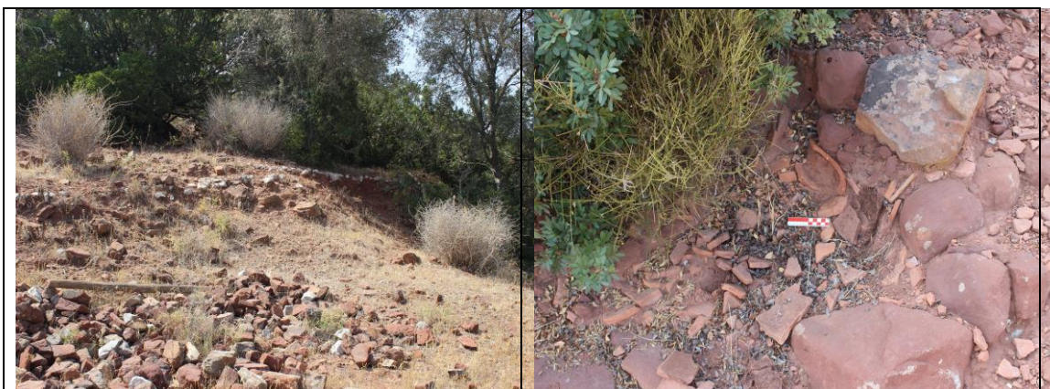
Figura 29 – Troço destruído de antiga calçada. À direita pormenor dos materiais de enchimento: fragmentos cerâmicos e pedra de grés. O revestimento superior é feito com pedra calcária.
