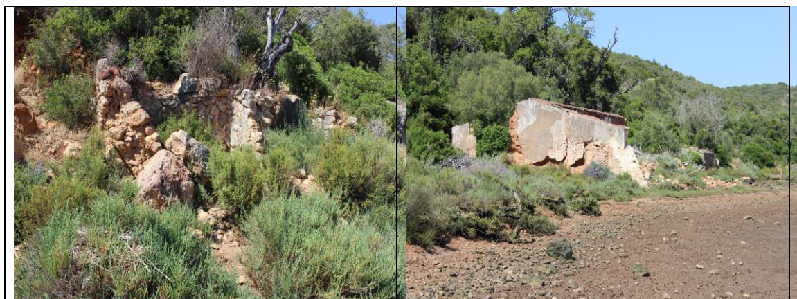
Figura 42 – Casal agrícola: edifícios em ruína
