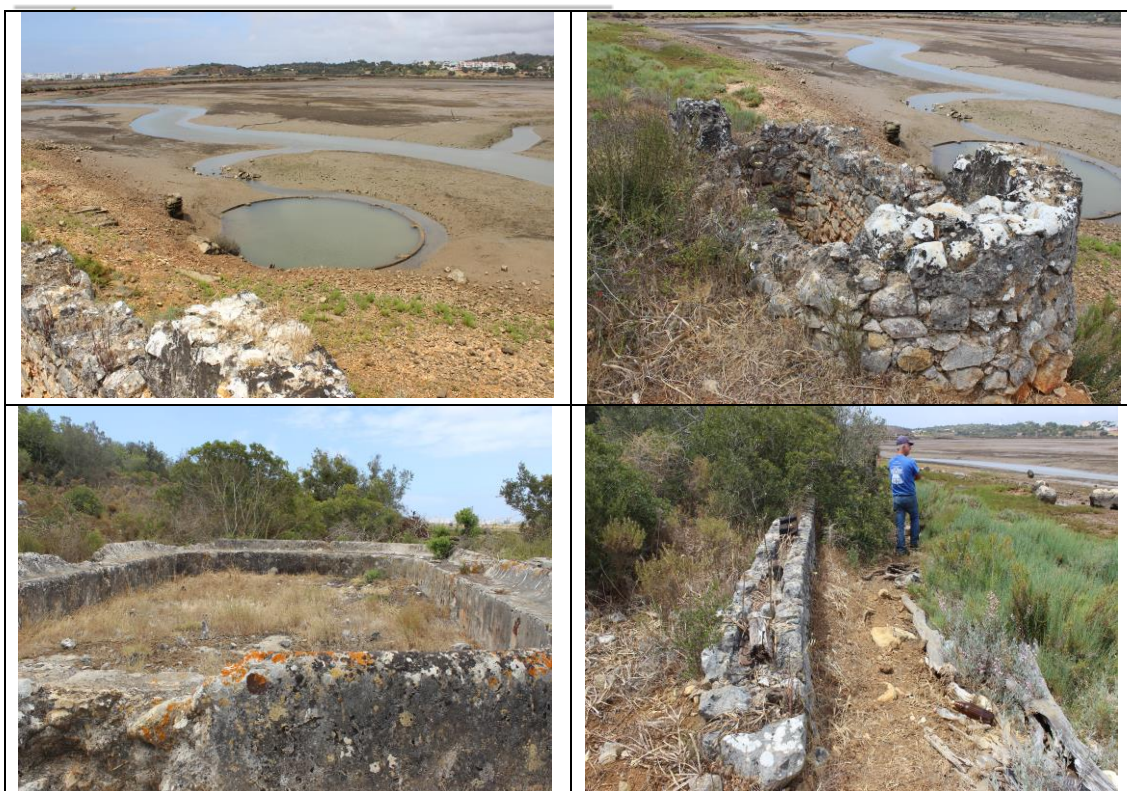
Figura 56 – Conjunto com poço, nora, tanque e levada (162)
