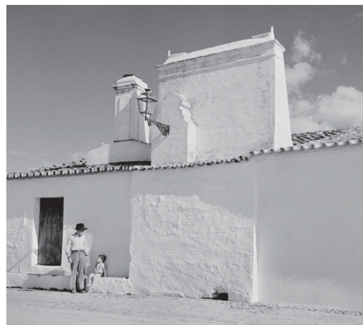
Figura 5 – Paredes cegas brancas / Grandes chaminés
