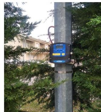
proximidade das habitações. Ambos os detetores possuem um display onde é visível e monitorizado a fuga de gás que por sua vez, aciona um alarme e interrompe automaticamente as operações de carga/descarga fechando as válvulas abertas. Em caso de deteção é realizada uma comunicação automática com a CDI e autómato que ordena a paragem de bombas, e acionamento do chuveiro de água pulverizada para arrefecimento.
