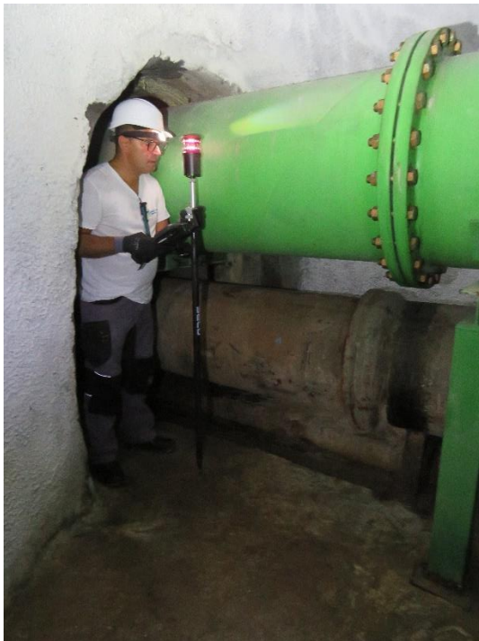
Foto 2 – Vista da entrada E do Aqueduto de Campo de Ourique
