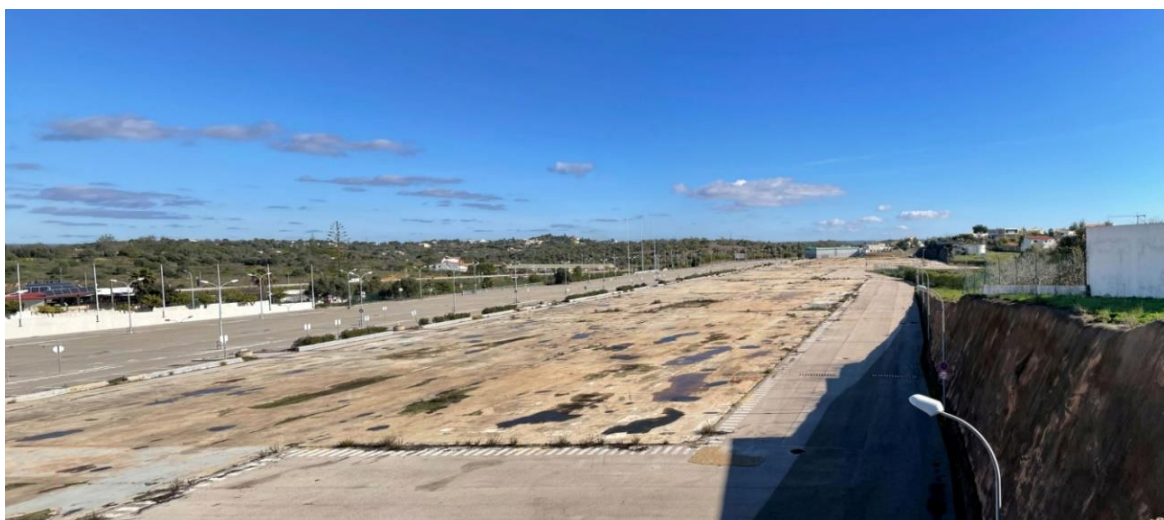
Figura 5.14.6 – Vista de ponte para a área de intervenção. A pesar da bacia visual ser relativamente contida, é forte a presença da grande superfície inerte, apenas pelos canteiros que se encontram na separação da zona de estacionamento da área em que se implantavam os edifícios do Retail Park destruído pelo incêndio.
