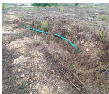
Fotografia 5. Vala de instalação de canalizações a céu aberto.
