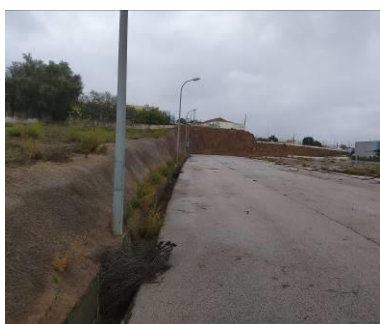
Fotografia 4. Perspetiva dos acessos e taludes impermeabilizados.
