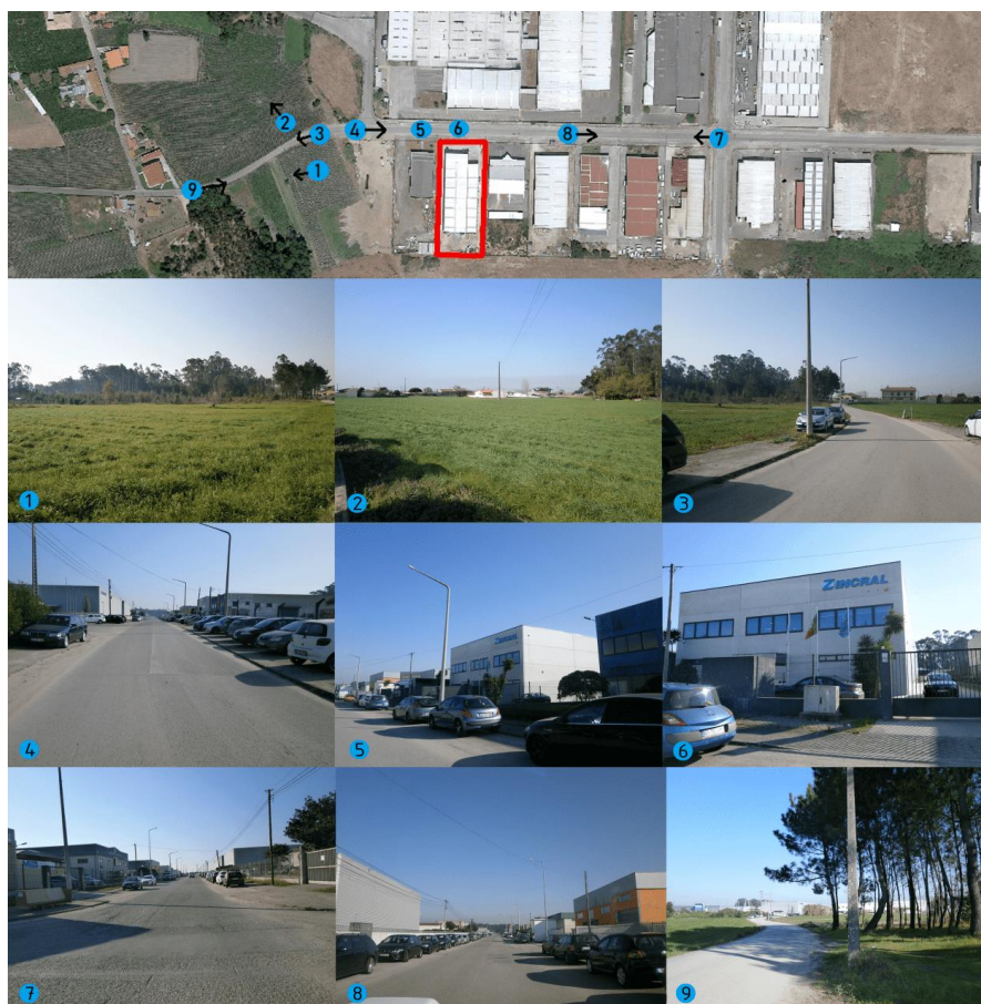
Figura 12 - Zona envolvente da ZINCRAL – Revestimentos, Lda
