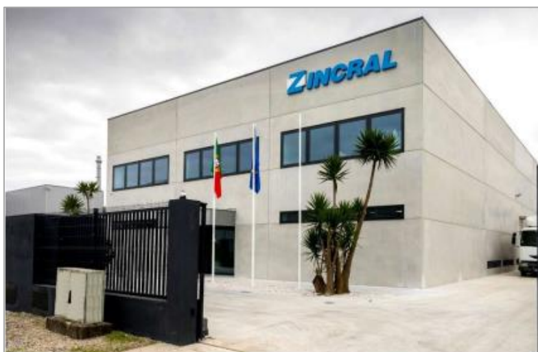
Figura 1 - Unidade industrial da ZINCRAL em Murtosa
