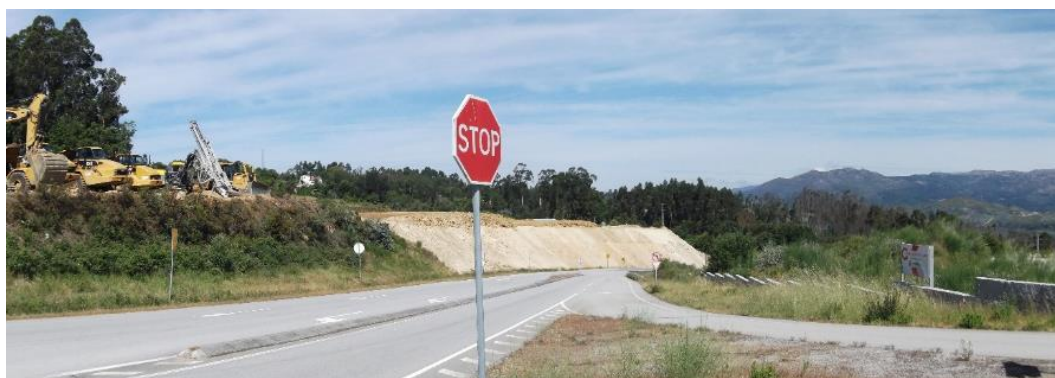
Área norte de ampliação da Zona Industrial do Monte Cavalo antes e durante as obras de terraplanagem
