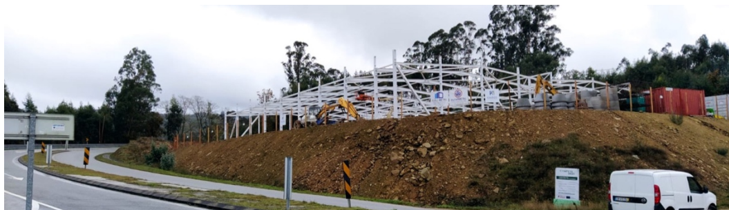
Fotografia da área terraplanada e do pavilhão industrial
