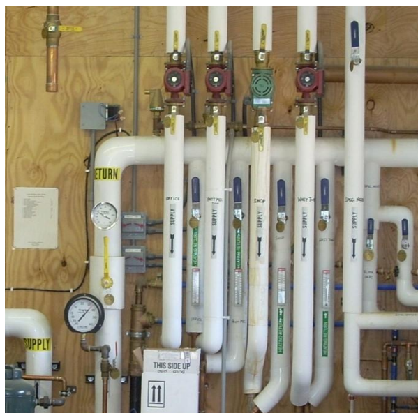
Figura 2 - Tubagens com identificação do fluido
