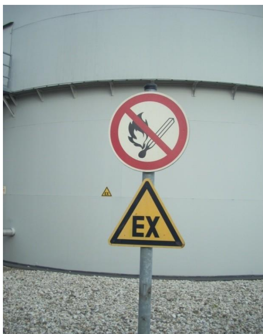
Figura 5 - Sinalização de zona ATEX e proibição de foguear
