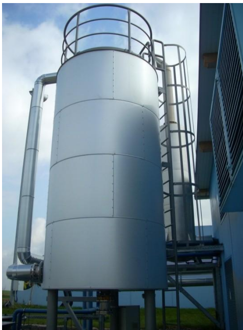
Figura 1 – Sistema de acesso a tanque de armazenamento
