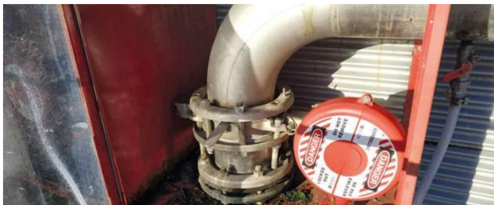
Figura 4 - Exemplo de aplicação de procedimento LOTO
