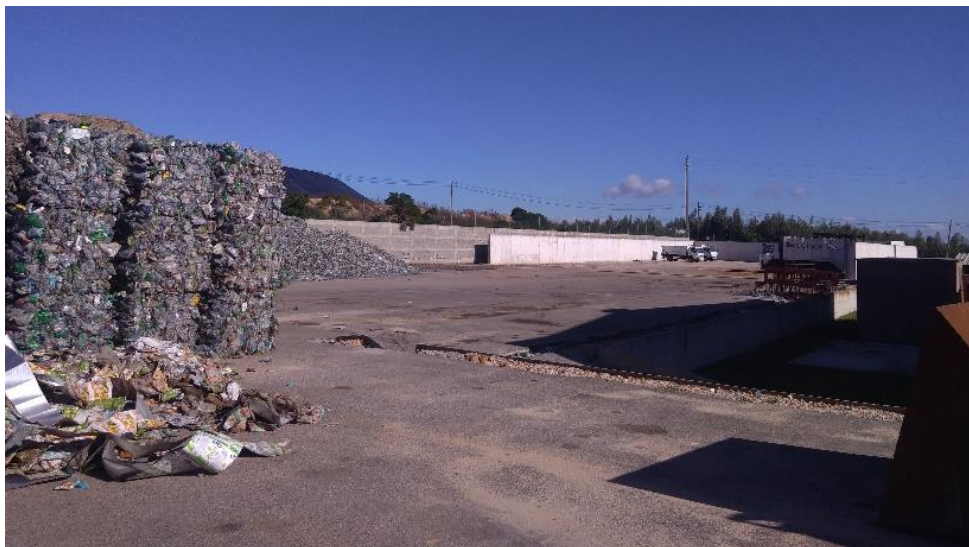
Fotografia 5.1, Fotografia 5.2 , Fotografia 5.3 – Imagens das áreas de implantação das novas edificações da UTMB
