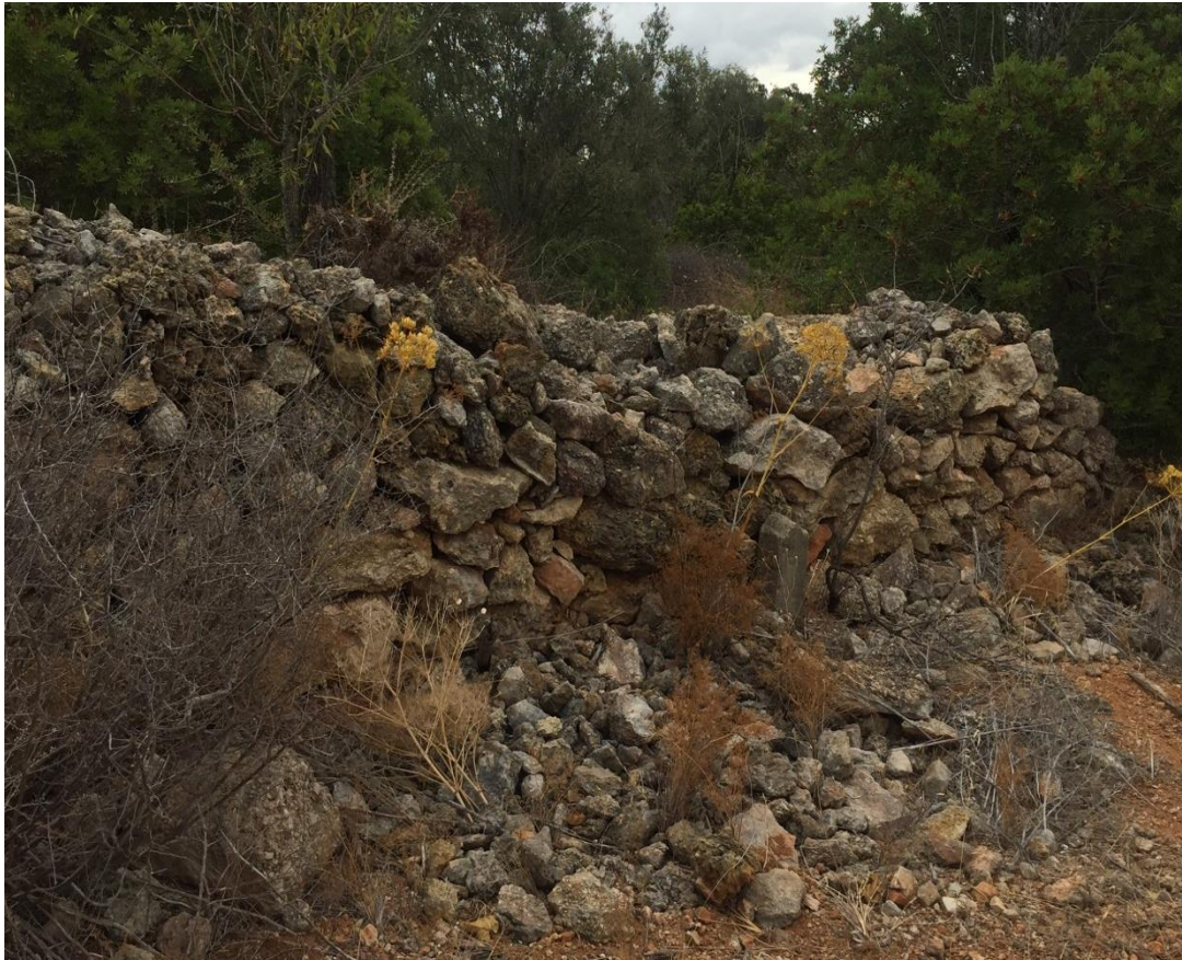
Fig. Muros de pedra seca
