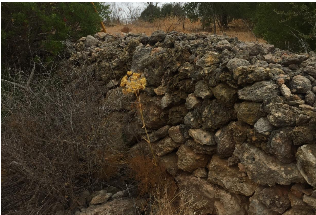
Fig. 11 Troço de muro de pedra seca
