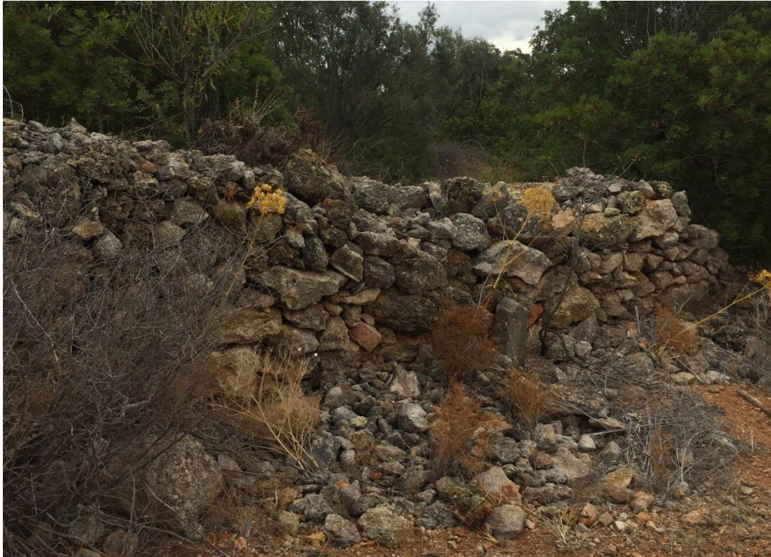
Fig. 10 Muros de pedra seca
