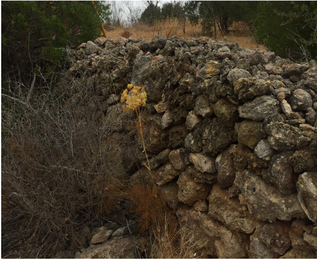
Fig. Troço de muro de pedra seca
