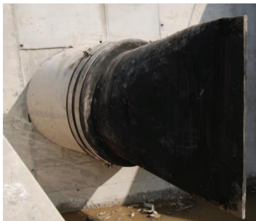
Ilustração 1. Exemplos de válvula de bico de pato (Fonte: CLA VAL)
