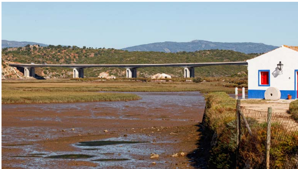
Figura 14 – Ponte sobre o Rio Arade (A22, Via do Infante) (em www.cenor.pt )
