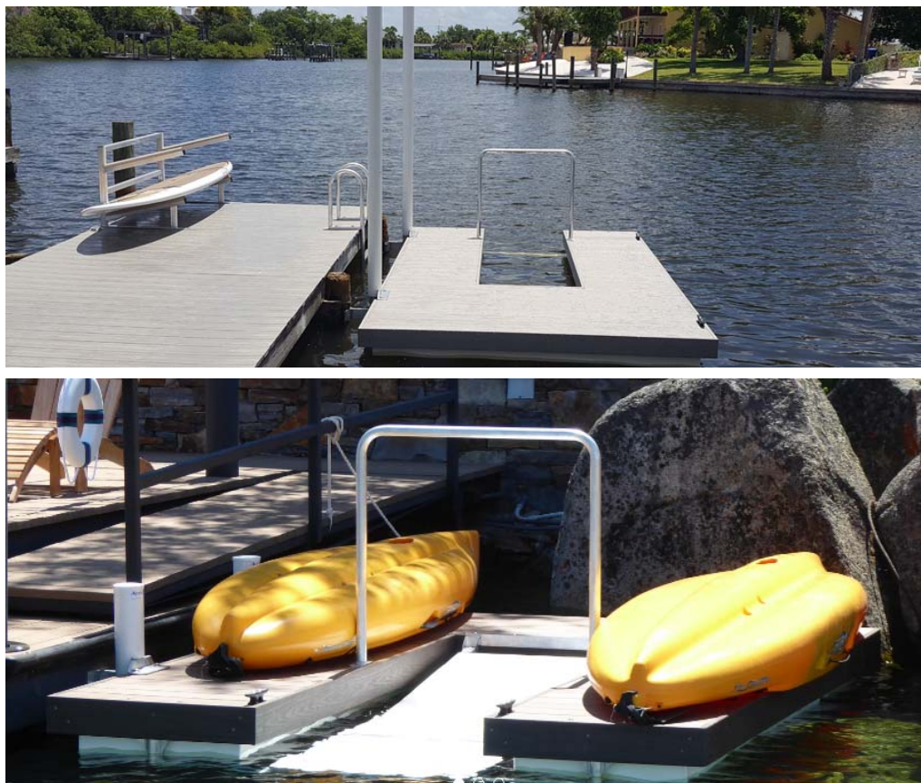
Figura 19 – Estrutura flutuante com rampa de acesso
