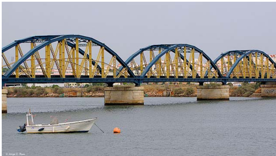
Figura 17 – Ponte Ferroviária de Portimão (em www.pontoblogue.com )
