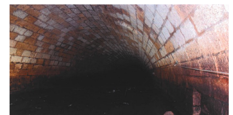
FOTOGRAFIA 1 RETIRADA NO INTERIOR DO CANEIRO DE ALCÂNTARA INTERFERÊNCIA Nº 429 s / escala
