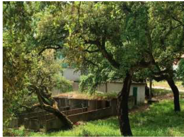
Fotografia 2 – Edificação existente na vizinhança do Projeto, a cerca de 240 m a nascente
