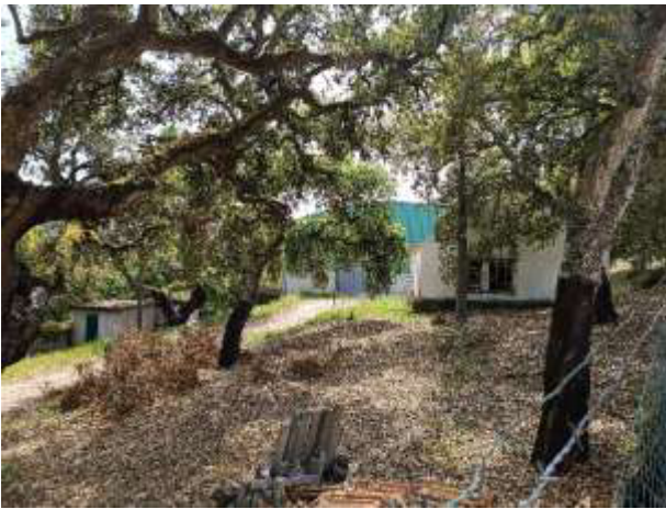
Fotografia 1 – Edificação existente na vizinhança do Projeto, a cerca de 240 m a nascente
