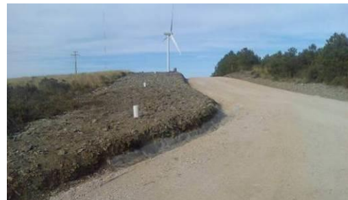
Vala de cabos após recuperação paisagística
