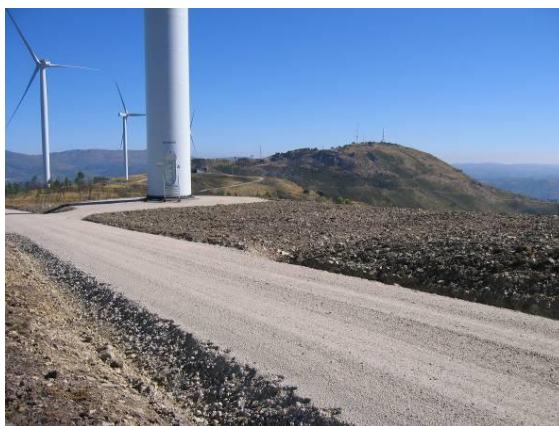
Fotografia 4.2 - Exemplo do aspeto de uma plataforma após renaturalização
