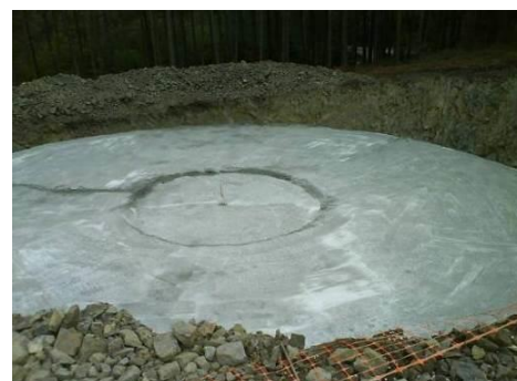
Fundação com betão de limpeza
