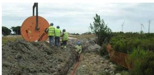
Colocação de cabo
