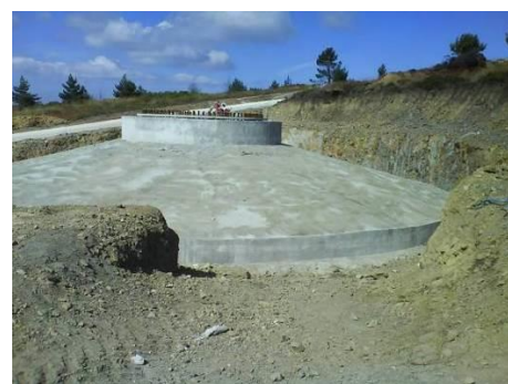
Fundação betonada e pronta para ser aterrada
