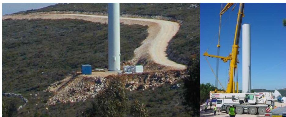
Fotografia 4.1 - Exemplo da plataforma de um aerogerador no decorrer da Fase de Construção
