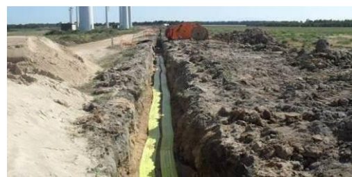
Colocação das lajetas de proteção mecânica
