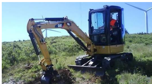
Trabalhos de escavação da vala
