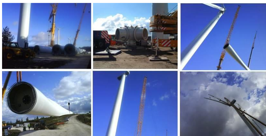
Fotografia 4.9 – Exemplo de transporte e montagem das pás de um aerogerador
