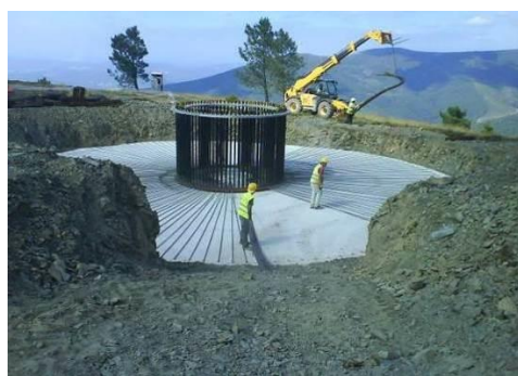
Trabalhos de armação de ferro
