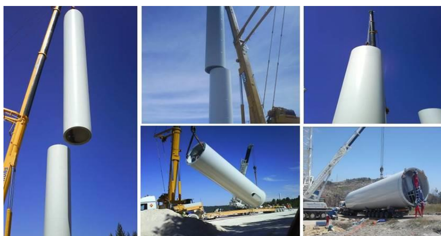
Fotografia 4.8 – Exemplo de trabalhos de montagem da torre de um aerogerador
