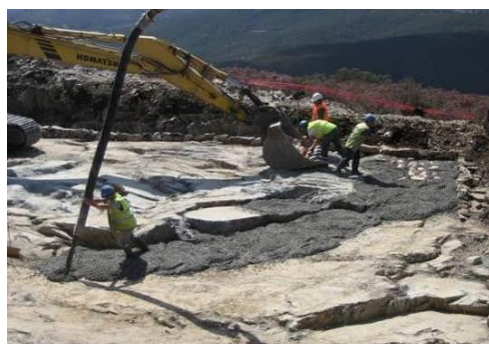
Betonagem de betão de limpeza na fundação
