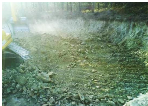
Escavação do cabouco
