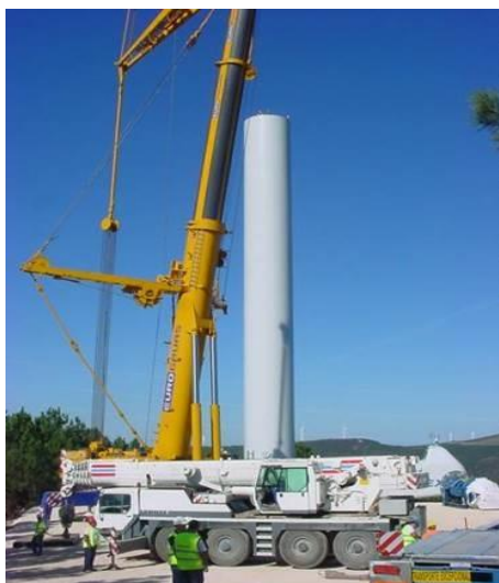
Fotografia 4.7 – Exemplo de uma plataforma para montagem do aerogerador
