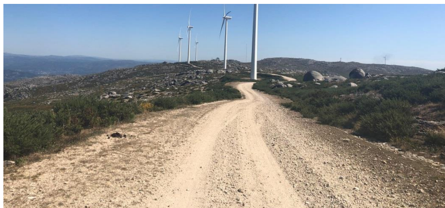
Fotografia 4.3 – Acessos internos existentes no Parque Eólico de Arga
