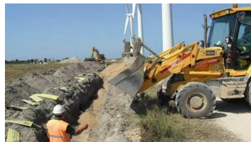
Colocação da areia na base da vala
