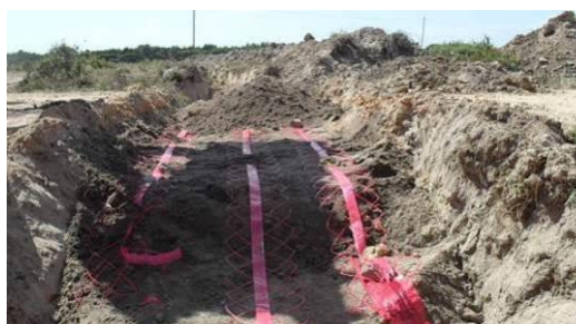
Colocação da rede de sinalização vermelha
