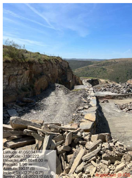
Figura 170: Fotografias do patamar implementado evidenciando a implementação da medida de suavização e estabilização dos taludes de inclinação acentuada com a criação de um patamar elevado na base.
