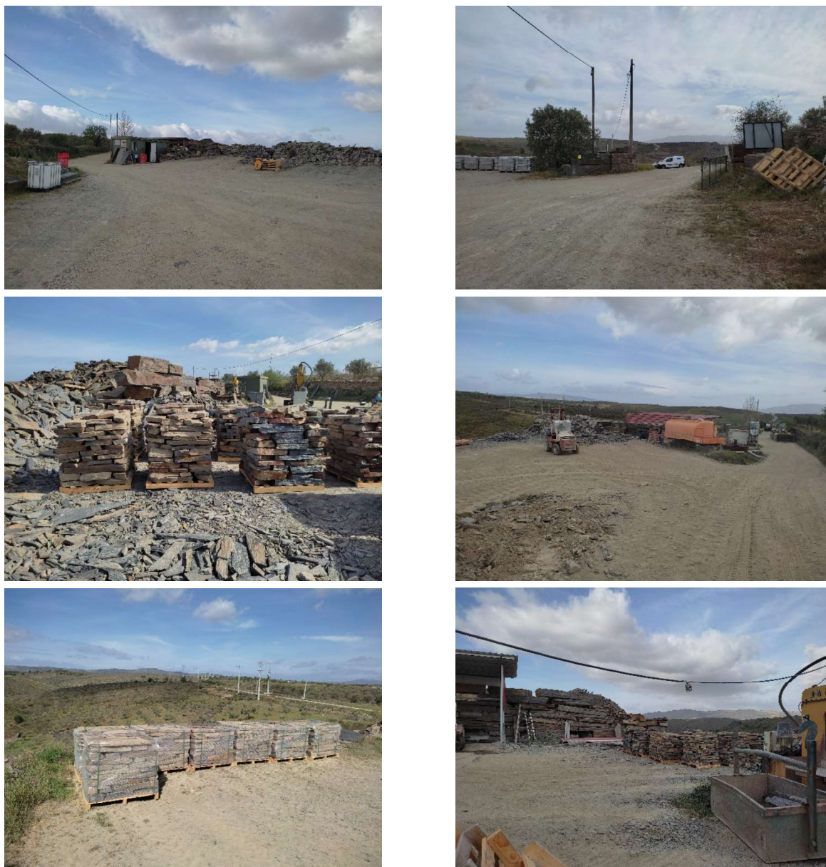
Figura 158: Fotografias dos espaços de circulação e stock dos produtos produzidos na Pedreira n.º 6637 “Vale de Videiro II”.
