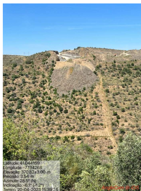
Figura 169: Fotografias da escombreira existente a sul evidenciando a implementação da medida de reperfilamento da escombreira.
