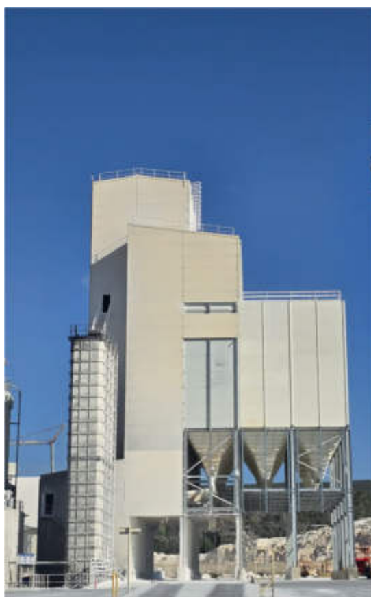
Figura 7 - Foto dos Silos Instalados na Microlime de Fátima
