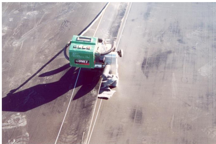
Soldadura por dupla pista
