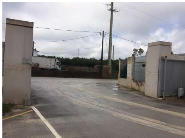
Foto 14 – Portão automático de entrada/saída da pedreira para a estrada da pedra alva.
