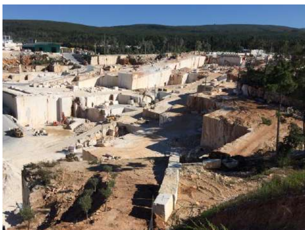
Foto 4 – Aspeto atual dos trabalhos de exploração na pedreira “Casal Farto N.º2”.
