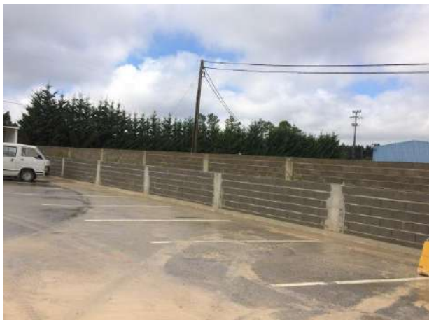
Foto 10 – Muros de delimitação da pedreira. Parque de viaturas com piso impermeável.
