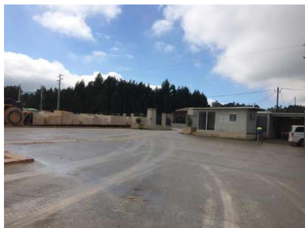
Foto 12 – Instalações sociais e sanitárias. Entrada pavimentada e parque de blocos.
