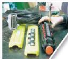
Cableado de balonera Pendant control wiring
