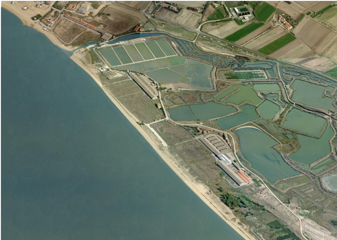
VISTA AÉREA DO EXISTENTE
