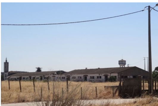
V7 – VISTA DA FACHADA SUL DO EDIFÍCIO DA PESCAL
