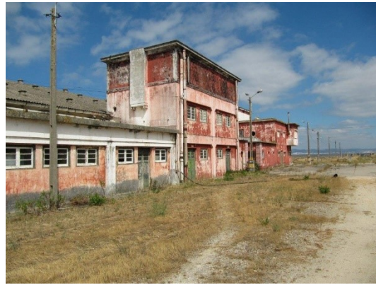
V2 – VISTA DA FACHADA ORIENTAL DOS EDIFÍCIOS DA SNAB
