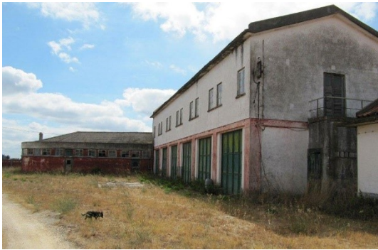
V5 – VISTA DO EDIFÍCIO SUL DOS ARMAZÉNS DA SNAB
