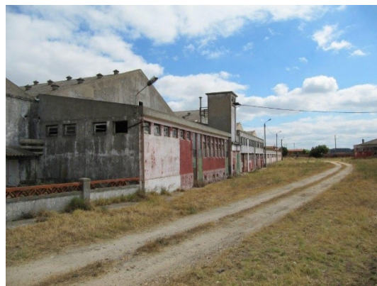
V4 – VISTA DA FACHADA SUL DO EDIFÍCIO DA SNAB
