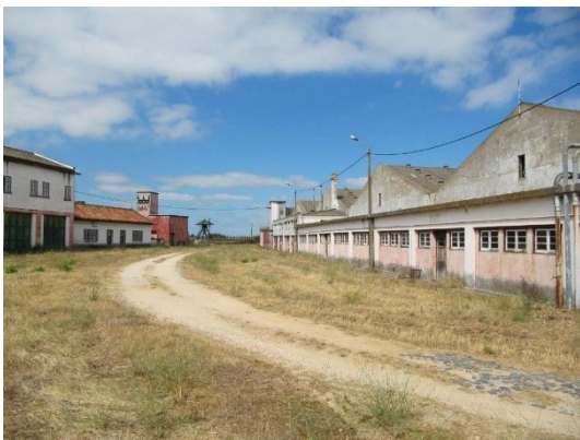
V3 – VISTA DA FACHADA SUL DO EDIFÍCIO DA SNAB
