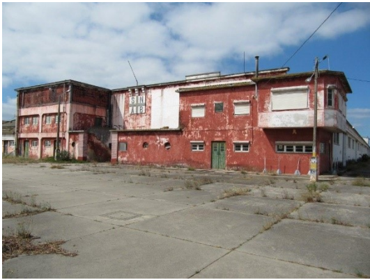
V1 – VISTA DA FACHADA ORIENTAL DOS EDIFÍCIOS DA SNAB
