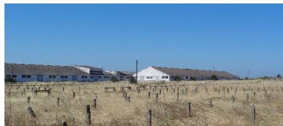
V6 – VISTA DA FACHADA NORTE DO EDIFÍCIO DA SNAB
