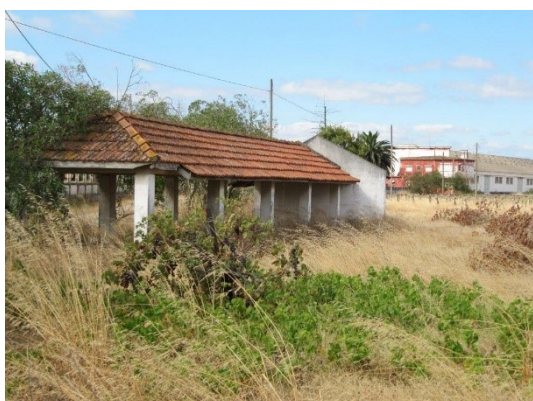
V3 – CONSTRUÇÃO PRÓXIMA DA ENTRADA DA PARCELA DA SNAB
