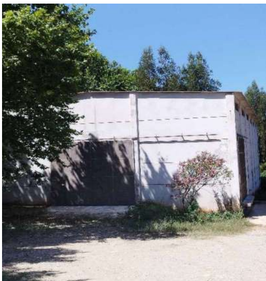
Ilustração 3- Pavilhão de armazenamento de estrume
