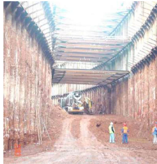
b) Contenção por estacas
