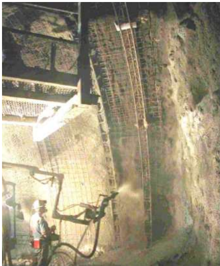
a)- projeção de betão sobre cambotas ligeiras treliçadas
