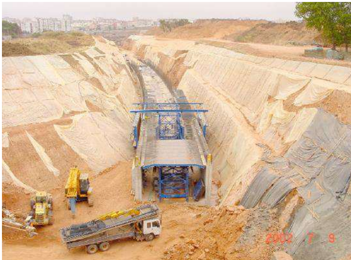
a) Escavação com taludes inclinados
