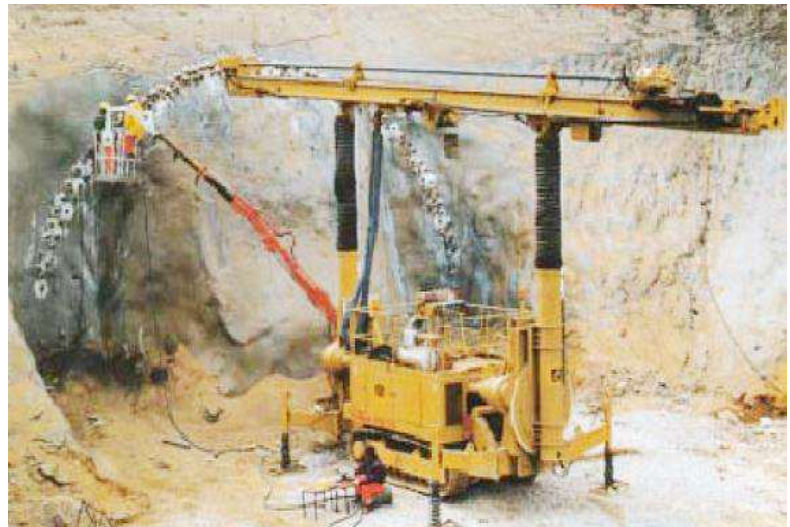
b)- Execução de sistema de enfiaçens num emboquilhamento
