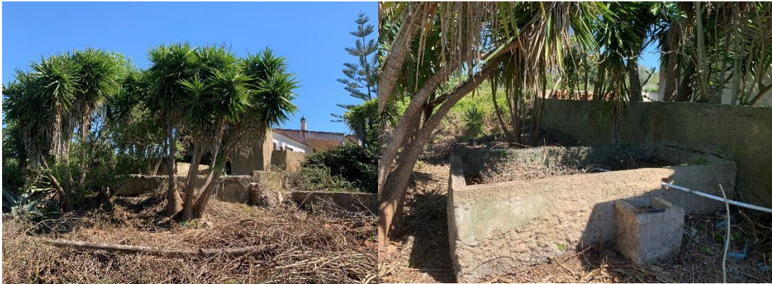
Figura 42. Enquadramento geral do poço P1
