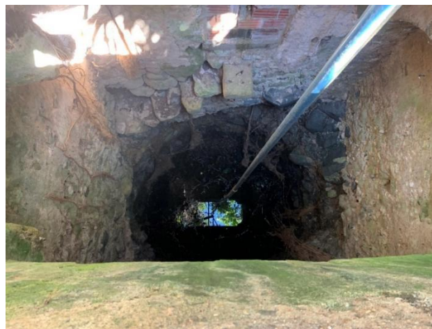
Figura 44. Enquadramento geral do poço P1
