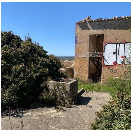
Figura 45. Enquadramento geral do poço P2
