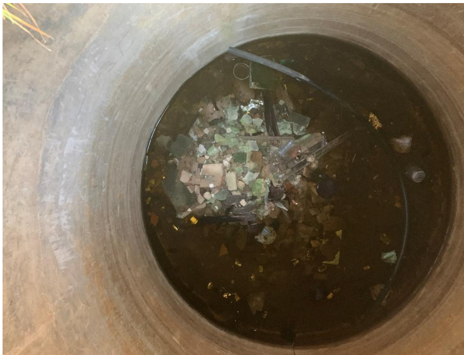
Figura 47. Aspeto do interior do poço P2
