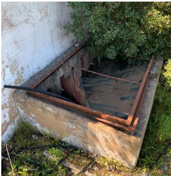
Figura 49. Pormenor da caseta de proteção do furo F1
