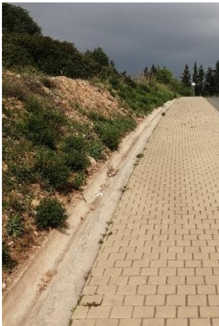
Figura 56. Aspecto das escavações e valas de drenagem
