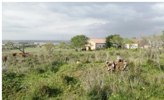
Figura 107. Edificado em ruínas
