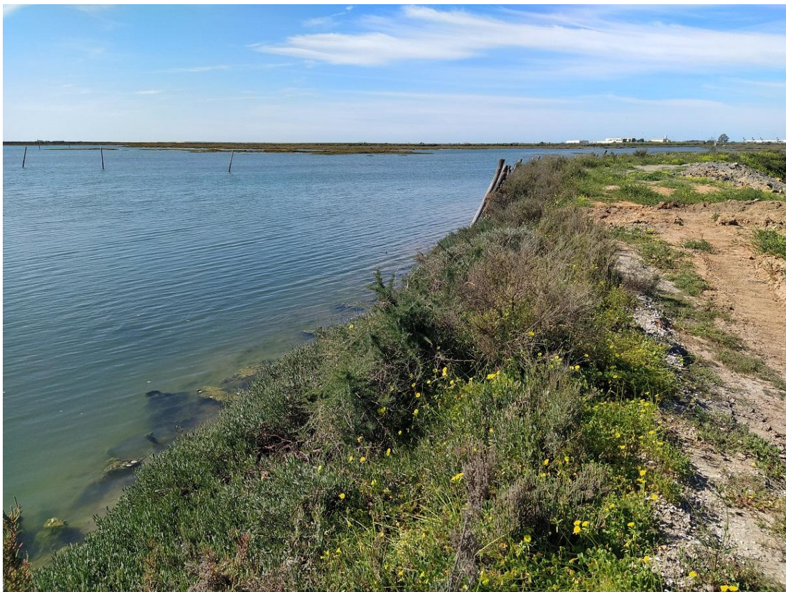
Fotografia 1 - Vista do combro existente.
