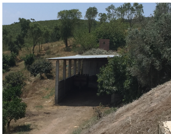
Figura 8.10 - Armazém de estrume do núcleo Sarruadas
