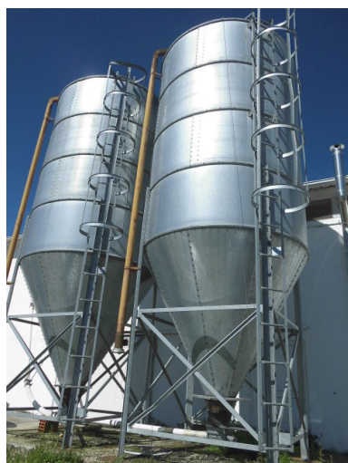
Figura 6.30 – Silos de ração (núcleo Valinhos)
