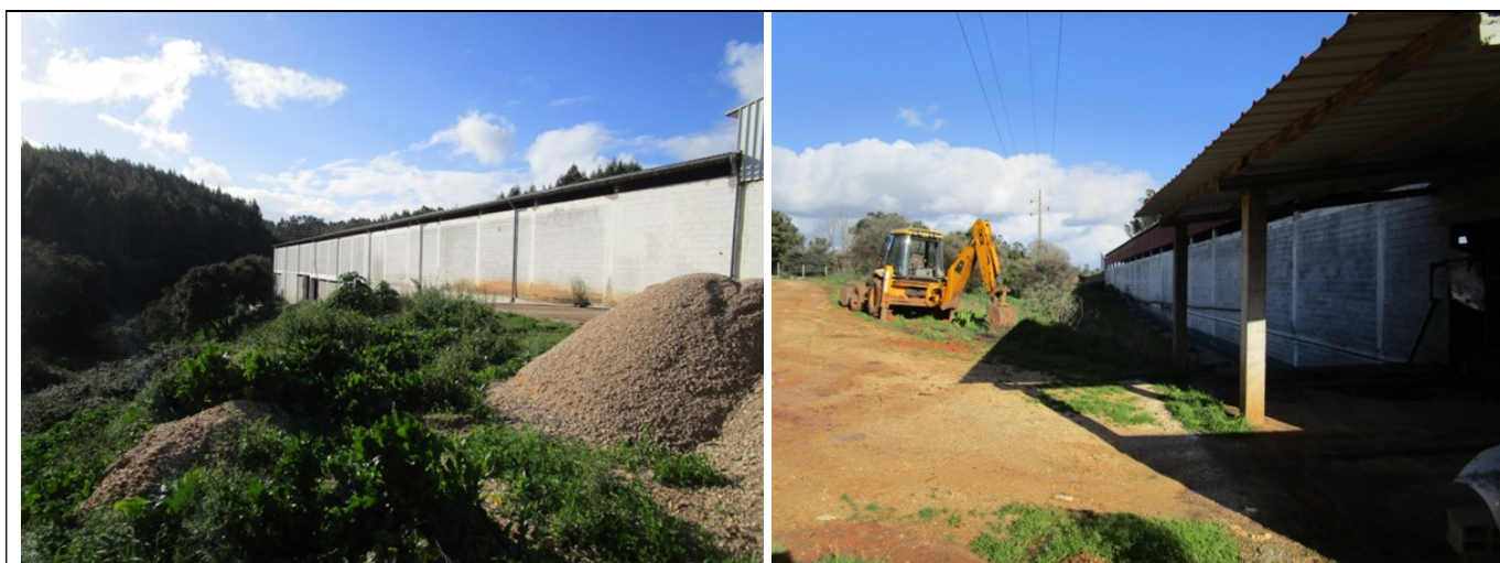
Figura 7.80 - Vista geral da implantação da instalação avícola: núcleo Barco Longo
