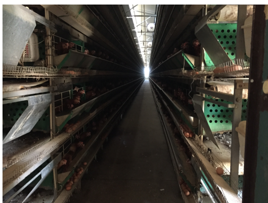
Figura 6.3 – Vista do interior do pavilhão 13
