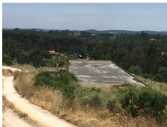
Figura 6.6 – Vista geral do pavilhão 14 (inacabado)
