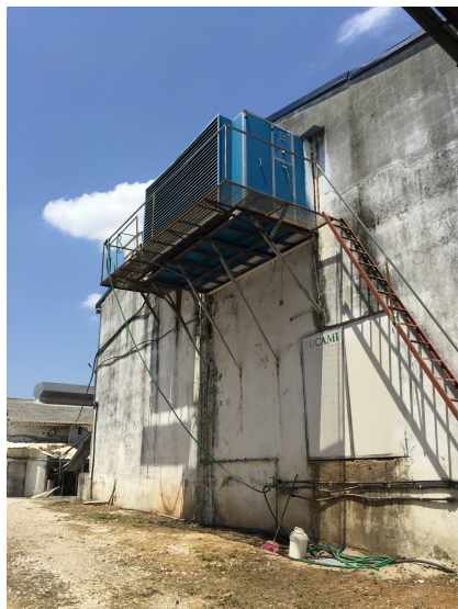
Figura 6.24 – Sistema de pré-secagem do estrume do pavilhão 9 do núcleo Pinascos
