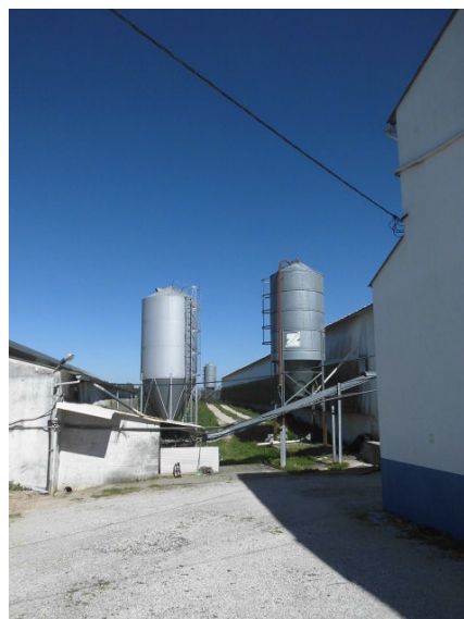
Figura 6.27 – Silos entre os pavilhões 9 e 10 do núcleo Pinascos
