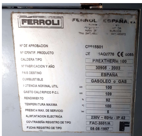
Figura 8.5 e Figura 8.6- Chapa dos geradores de ar quente com as características dos mesmos dos núcleos de Valinhos e de Sarruadas, respetivamente.
