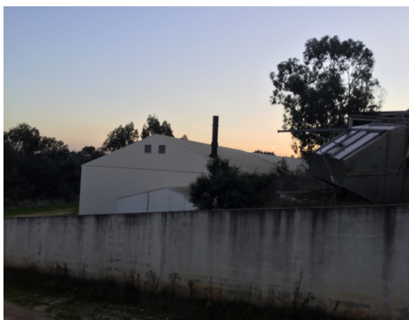
Figura 7.77 - Unidade industrial distanciada cerca de 310 m do núcleo Sarruadas, a sudeste
