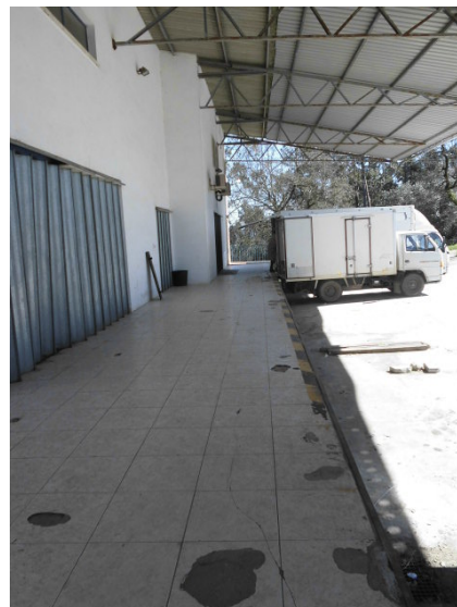
Figura 6.13 – Cais de carga do Centro de Inspeção e Classificação de Ovos
