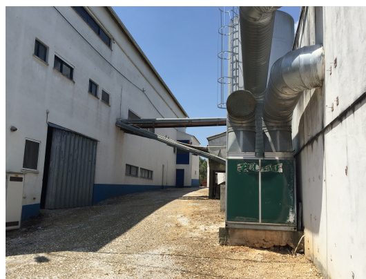
Figura 6.2 – Vista geral do pavilhão 13 e passadeira de transporte de ovos para o Centro de Inspeção e Classificação de Ovos
