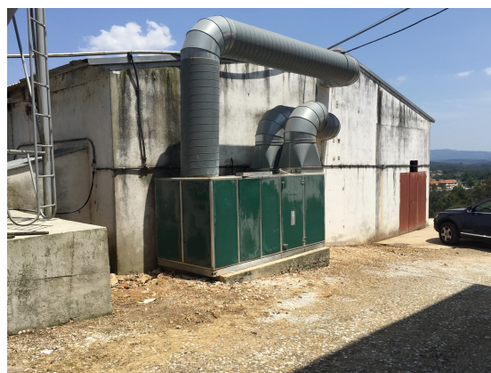
Figura 6.7 – Vista da parte frontal do pavilhão 13
