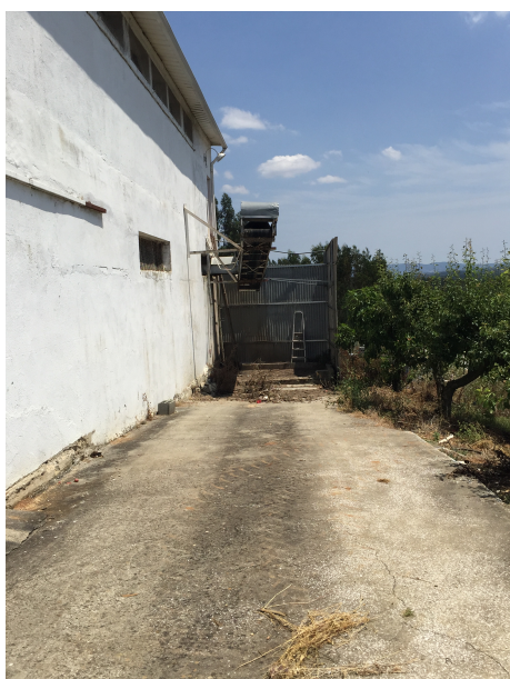
Figura 8.9 - Local de carga de estrume em veículo com reboque para envio para o armazém de estrume
