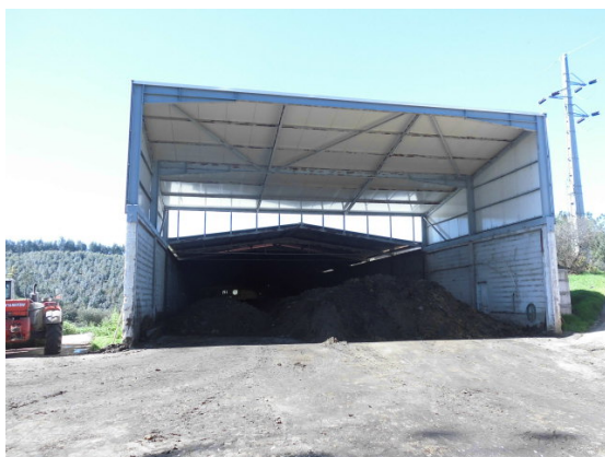
Figura 6.21 – Vista frontal do pavilhão de estrume
