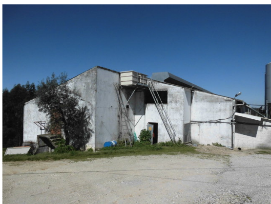
Figura 6.5 – Vista geral do pavilhão 9
