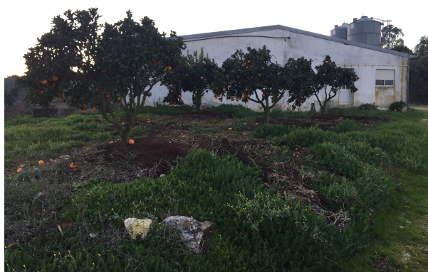
Figura 7.73 – Vista sobre o topo do pavilhão de Sarruadas, com área florestal de fundo e envolvente e presença de pomar na propriedade do núcleo
