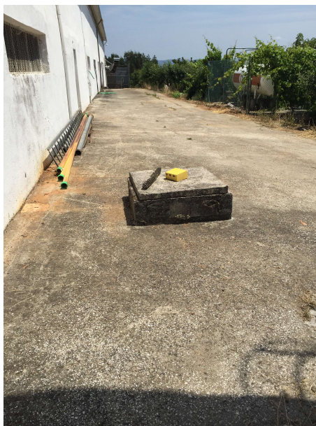
Figura 8.15 – Fossa séptica estanque para chorumes do núcleo - Valinhos
