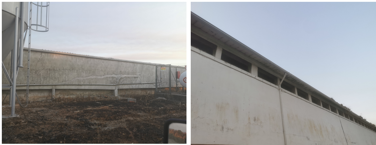
Figura 6.36 e Figura 6.37 – Algerozes dos Pavilhões
