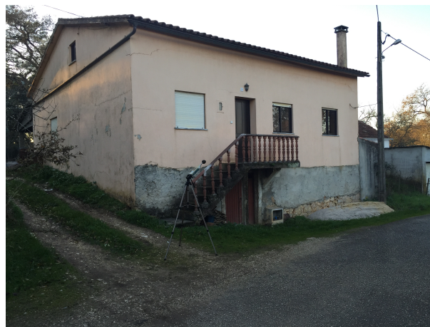
Figura 7.38 – Habitação a cerca de 125 metros do núcleo Pinascos
