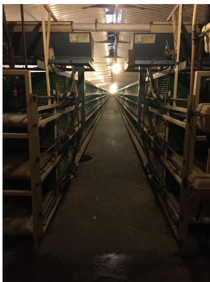
Figura 6.19 – Vista do interior do pavilhão de recria
