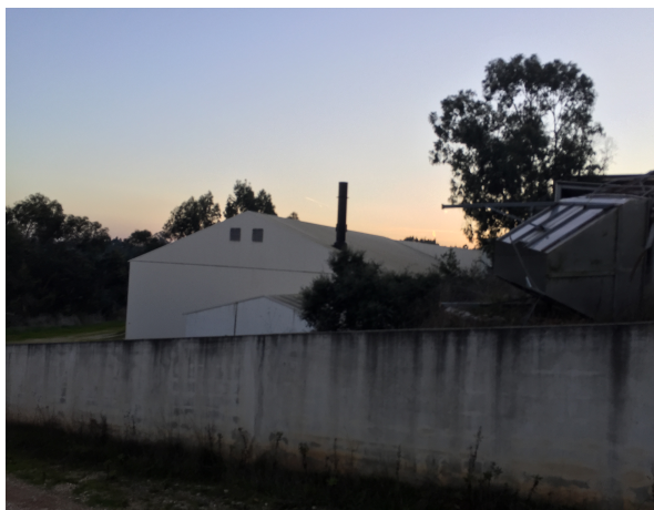
Figura 7.32 - Unidade industrial distanciada cerca de 310 m do núcleo Sarruadas, a sudeste
