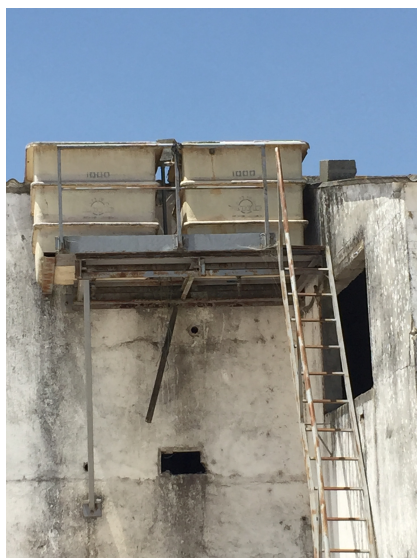
Figura 6.24 – Sistema de pré-secagem do estrume do pavilhão 9 do núcleo Pinascos
