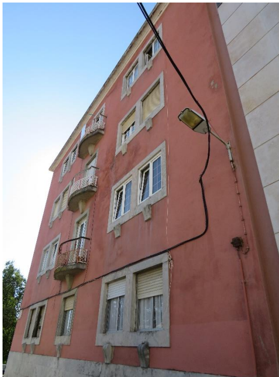
Foto 2 – Fachada E do edifício
