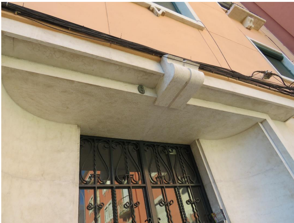
Foto 2 – Entrada no edifício
