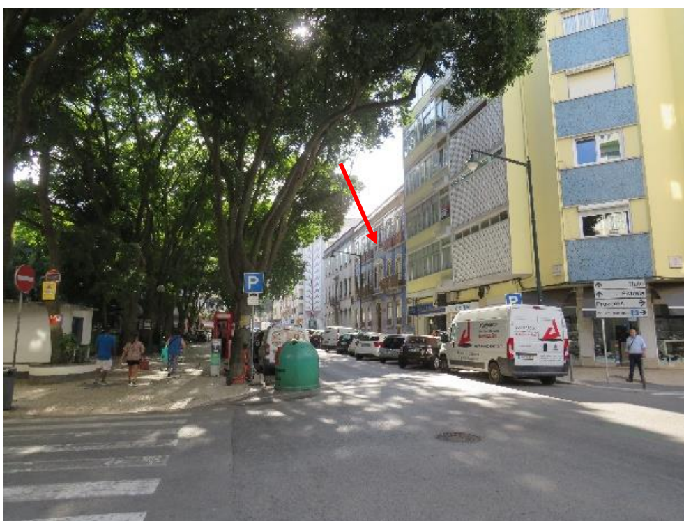
Foto 1 – Vista envolvente a norte do edifício
