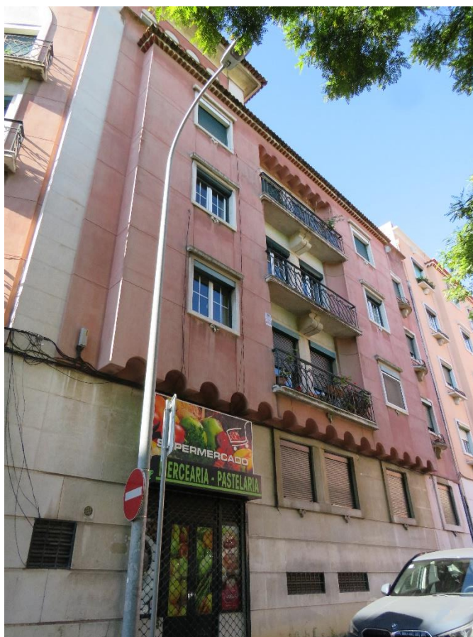
Foto 2 – Fachada N do edifício
