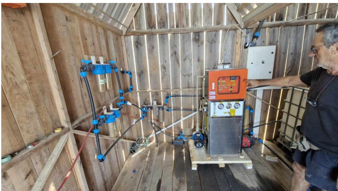
Figura 16 - Sistema de dessalinização instalado.
