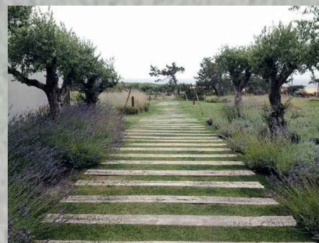
PAVIMENTO COM TRAVESSAS DE MADEIRA
