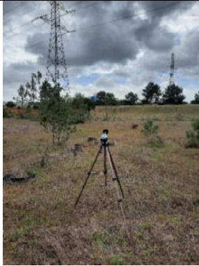
Imagem 2 - Vista desde o ponto de medição em direção à instalação em análise.
