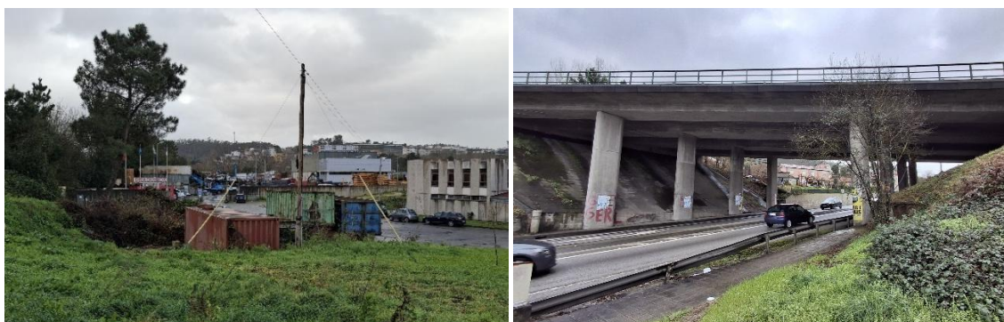
Figura 92 e Figura 93. Acumulação de estruturas obsoletas na entrada da BRAGUINOX e estrutura rodoviária.
