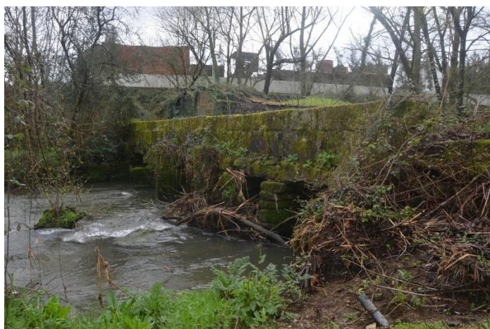
Figura 126. Ponte em pedra sobre o Rio Este (NO/SO).
