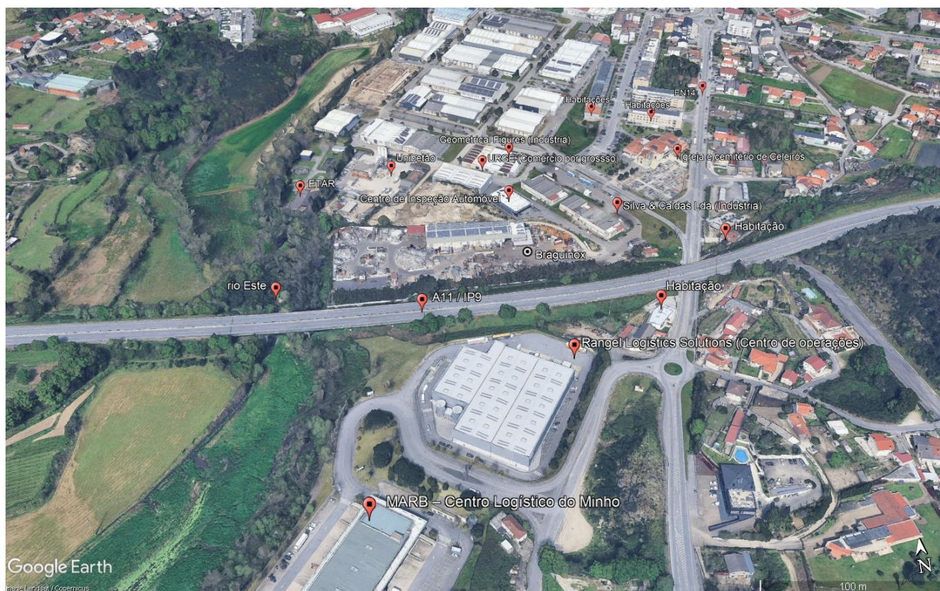
Figura 106. Imagem aérea da envolvente da BRAGUINOX, com destaque para as instalações vizinhas e alvos sensíveis (Google Earth).
