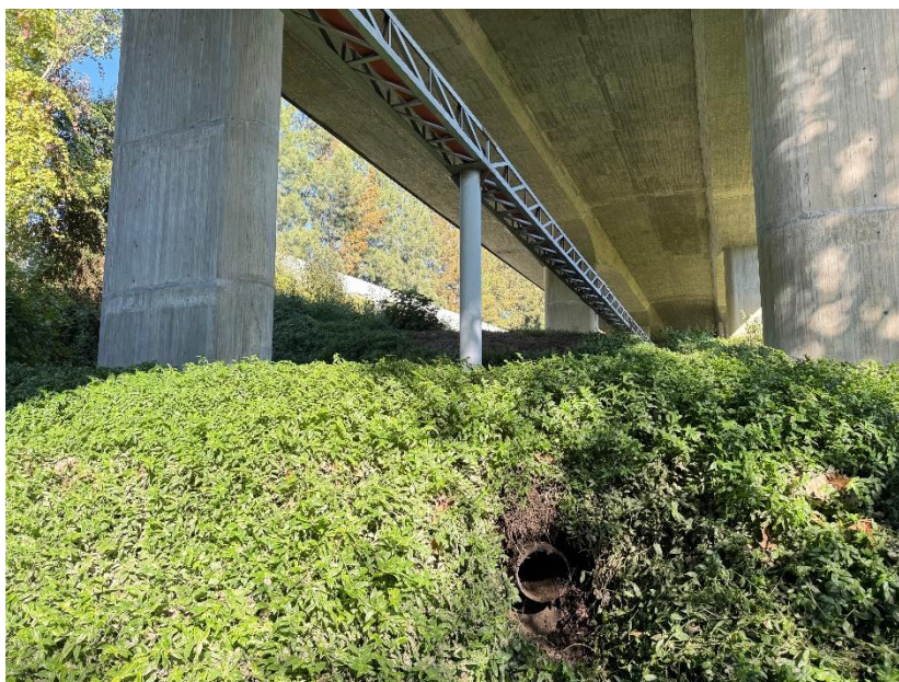
Figura 134. Local do ponto de rejeição (EH1) do separador de hidrocarbonetos, junto ao rio Este.
