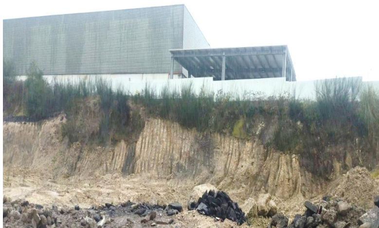
Figura 59. Afloramento rochoso com evidência da camada de solo, localizado na envolvente da área em estudo.
