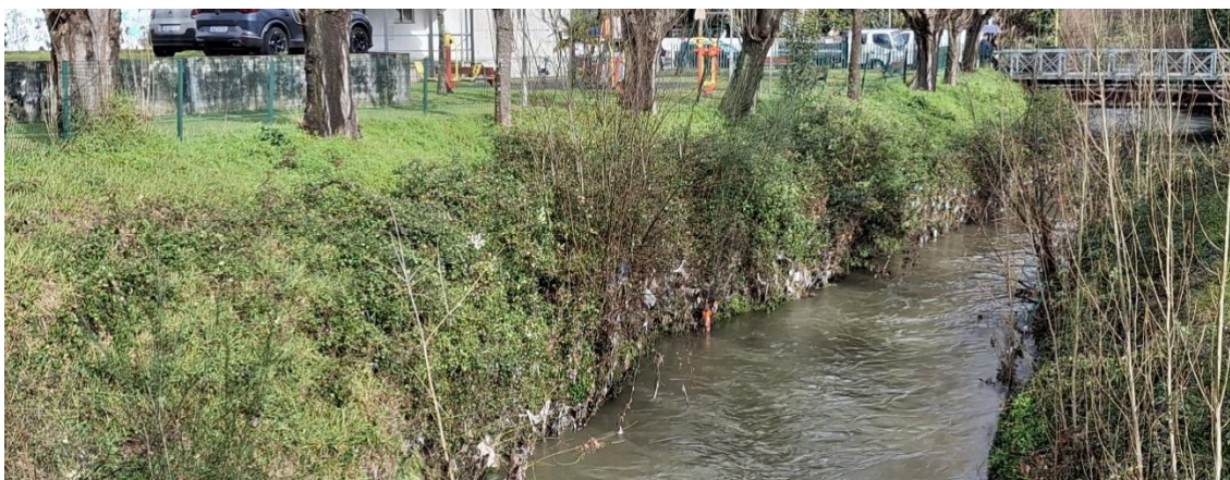
Figura 89. Margens artificializadas do rio Este no Parque Industrial de Celeirós.
