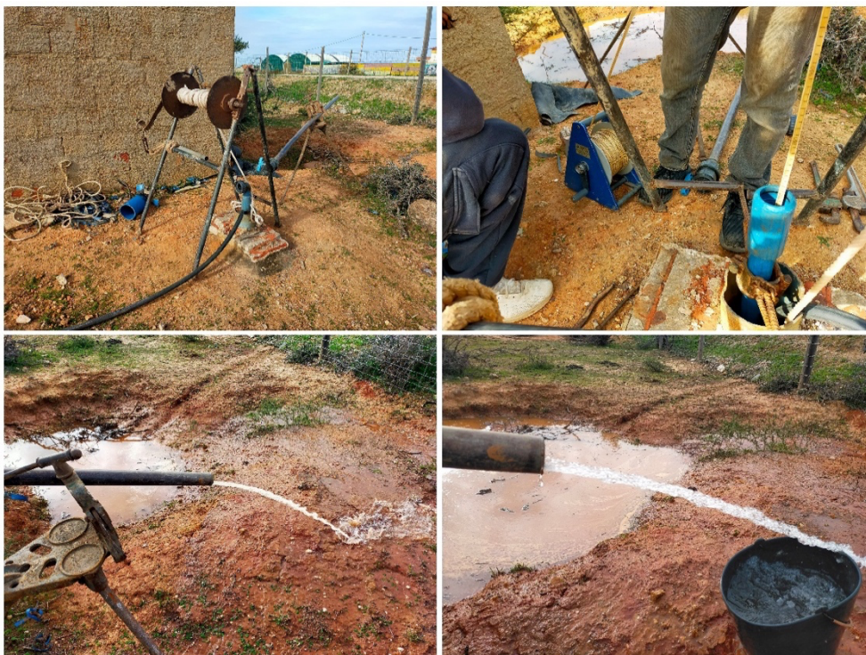
Figura 1. Operação de limpeza e desenvolvimento de furo vertical existente dentro dos limites da área de Projeto.
